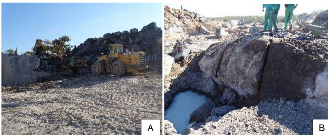
Figura 13 A) Limpeza do local de interesse e B) Abertura de caixa e canal para a abertura de nova frente de trabalho.
