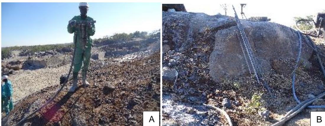
Figura 14 A) Martelo pneumático e B) Barrenas para a execução de furos verticais.
