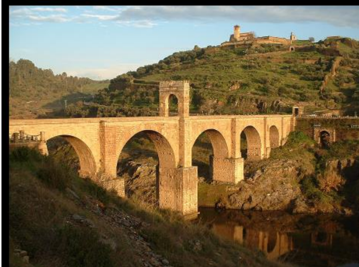
Ponte romana de Alcântara
