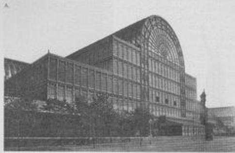
Joseph Paxton, Palácio da Cristal, 1850-51, vistas exterior (A) e interiores (B e C) Possuía 563 m de comprimento, 124 de largura e 30 de altura e foi construído em apenas seis meses, graças ao uso de módulos prefabricados e estandarizados e montados no local.
