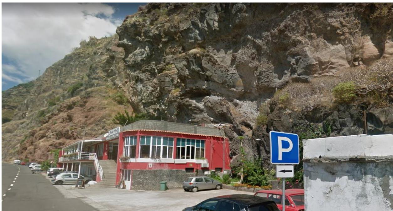
Foto 8 – Elevada Vulnerabilidade de Movimentos em Massa (Município da Calheta)
