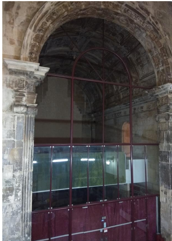
Fig. 23: Capela de Jesus, Convento de São Domingos, 2018. Fonte: autora
