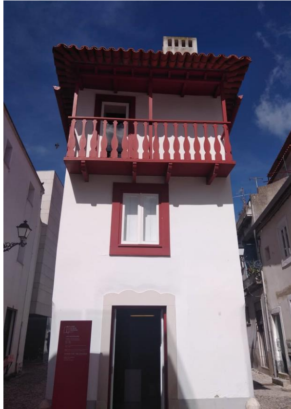
Fig. 32: Casa dos Pintores, Leiria, 2019. Fonte: autora
