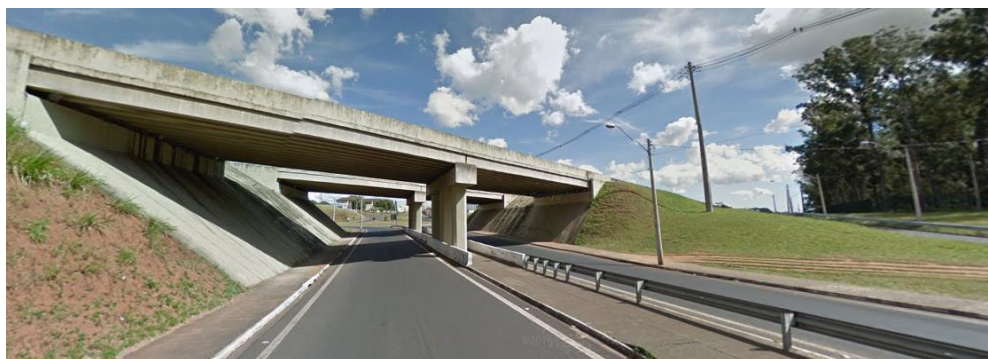
Figura 2.1 – Ponte de concreto armado na rodovia SP-310
