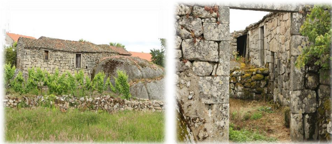
Figura 36 - Muros de terrenos de cultivo e Casas de habitação abandonadas, Pendilhe
