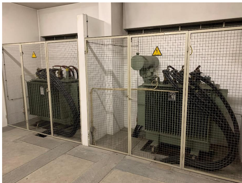
Figura 11 – PTC do edifício DEEC
