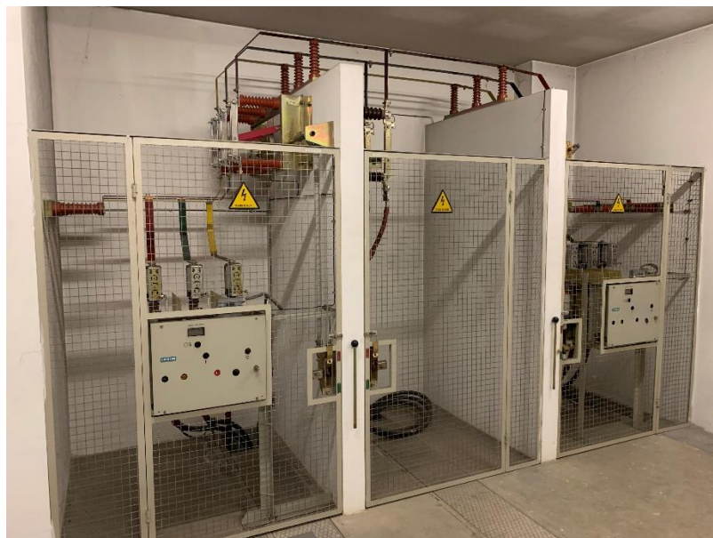
Figura 10 – PTC do edifício DEEC
