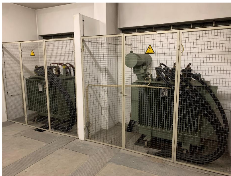
Figura 16 – PTC do edifício DEEC
