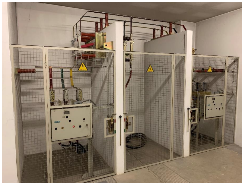
Figura 15 – PTC do edifício DEEC
