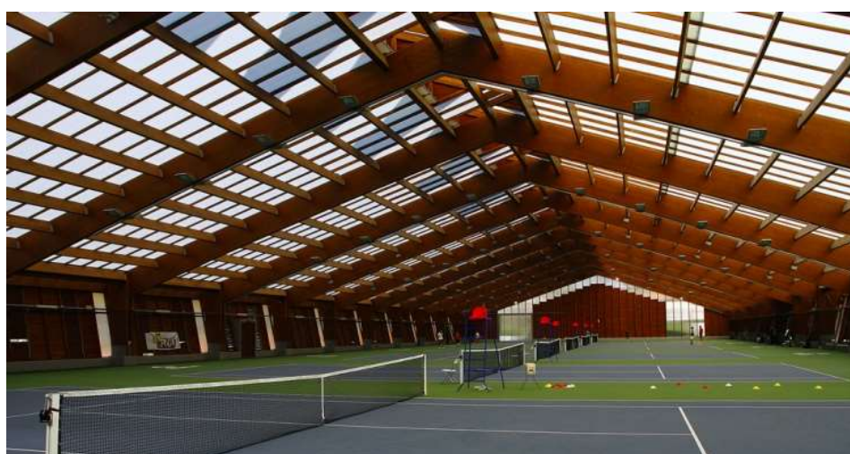
Figura 2.2 – Nave cobertura courts ténis do Jamor [Imagem 2]
