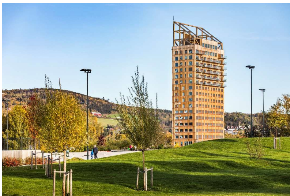
Figura 2.1 – Edifício Mjøstårnet [Imagem 1]
