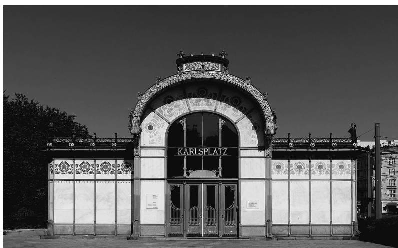
007 fachada do Pavilhão Karlsplatz Obra Wagner 1898
