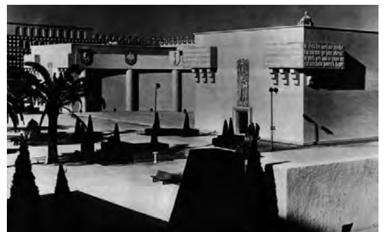
Fig. 91 - Pavilhão da Colonização, Carlos Ramos
