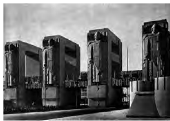
Fig. 84 - Pórtico da Entrada Sul
