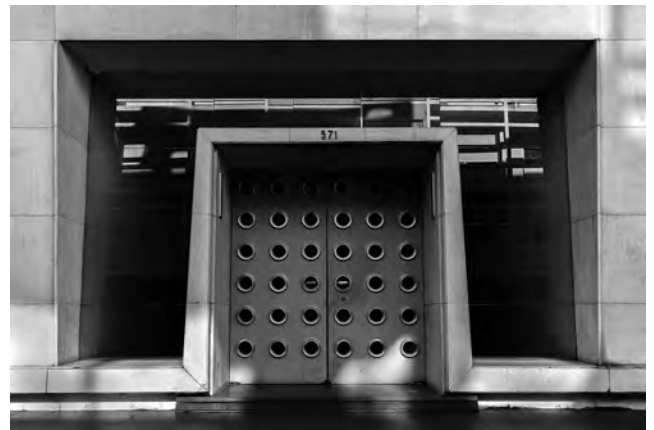
Fig. 110 - Foto do lado exterior da porta principal
