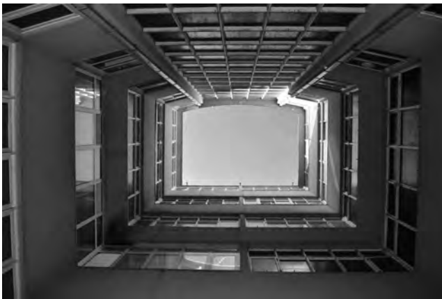
Fig. 109 - Foto do saguão no Piso Rés-do-Chão
