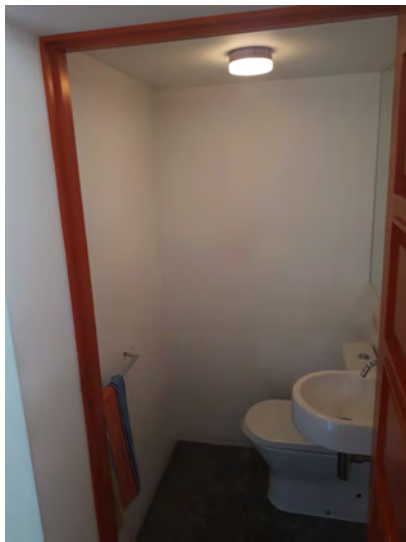
Fig. 183 - Fotografia da instalação sanitária
