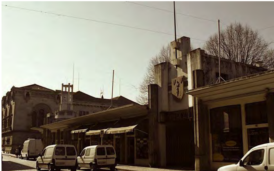
Fig. 203 - Foto da Fachada Nordeste do Mercado Municipal de Guimarães (1927) de José Marques da Silva
