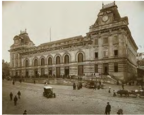
Fig. 66 - Foto da Estação de S. Bento (1896), Porto
