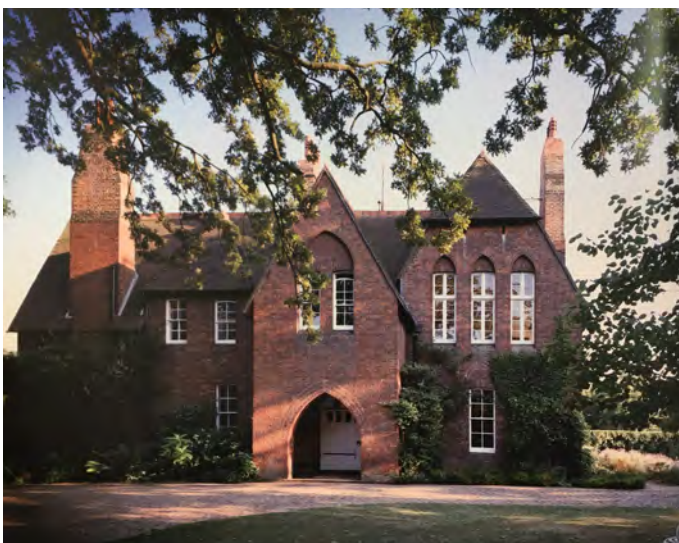
Fig. 14 - Fotografia do Alçado Norte da Red House, Kent
