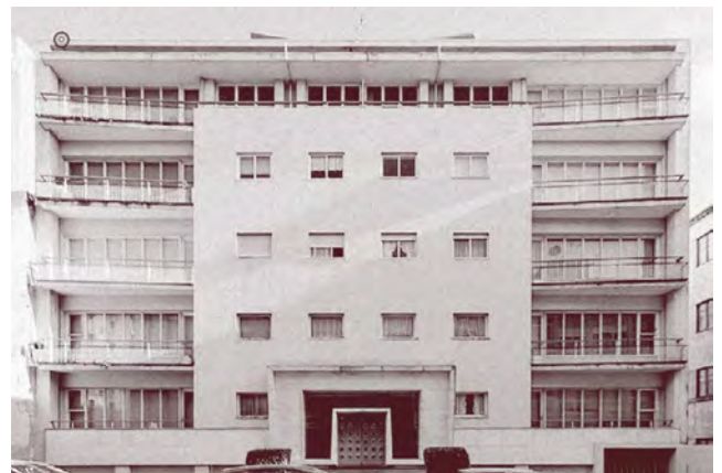
Fig. 112 - Foto do Alçado principal do Bloco da Carvalhosa
