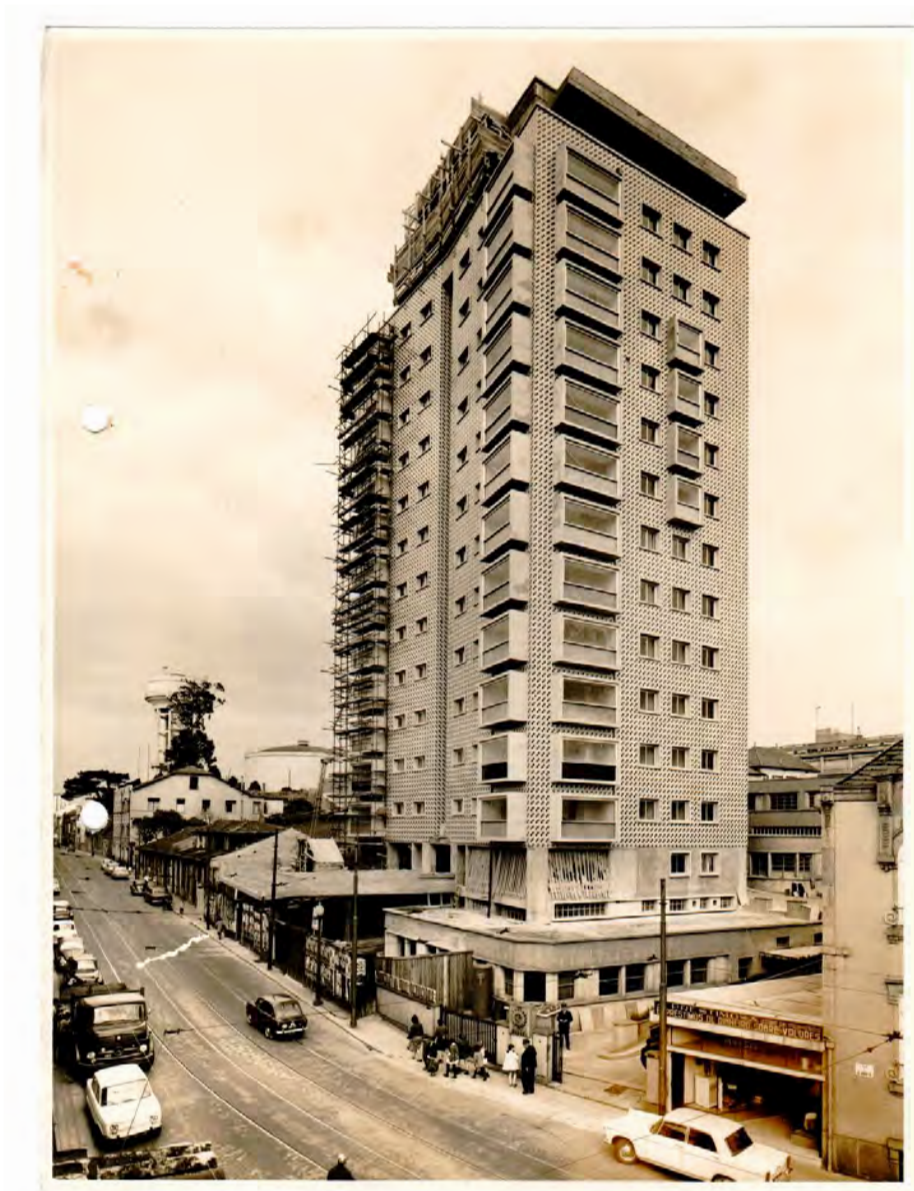
Fig. 229 - Foto da Torre do Miradouro em construção, s/ data
