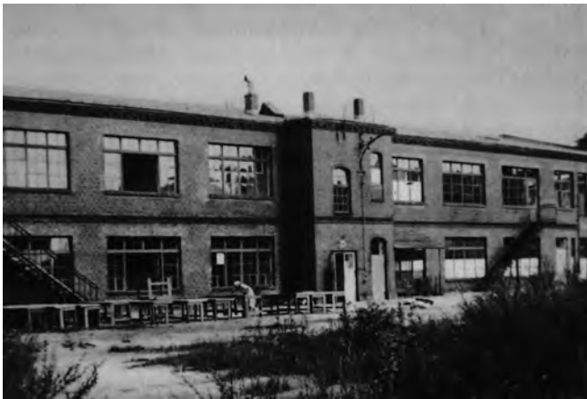
Fig. 20 - Edifício da Bauhaus em Berlim, Birkbusch Street 49 (1932)
