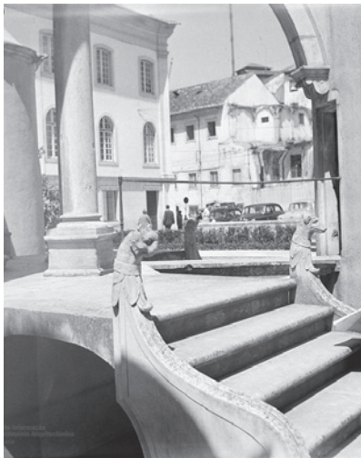
Fig. 95 - Promenor das escadas da fonte após os restauros por parte da DGEMN.
