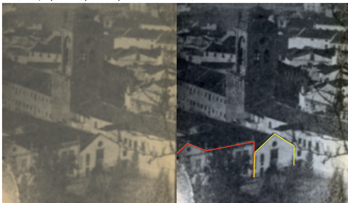
Fig. 77 - Pormenor da fotografia Vista para Montarroio (e respetiva edição da imagem, à direita); É possível ver-se o alçado nascente do claustro da Manga (a vermelho) e o alçado nascente do antigo dormitório (a amarelo); Coleção particular, publicado por Alexandre Ramires, 2001.
