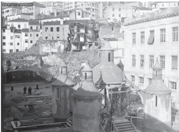
Fig. 97 - Diferentes, e mais ligeiros, trabalhos de restauro, em 1960.
