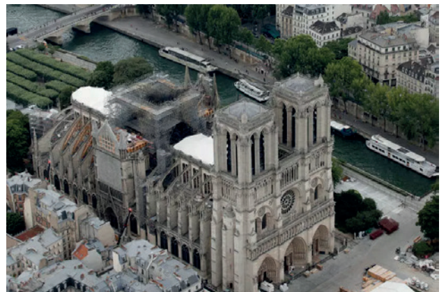
Fig. 28 - Fotografia aérea da Catedral de Notre-Dame (posterior ao incêndio de abril de 2019).
