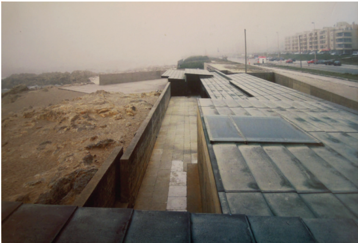
Fig. 186 - Fotografia das Piscinas de Leça de Palmeira; vista a partir da cobertura, para norte.
