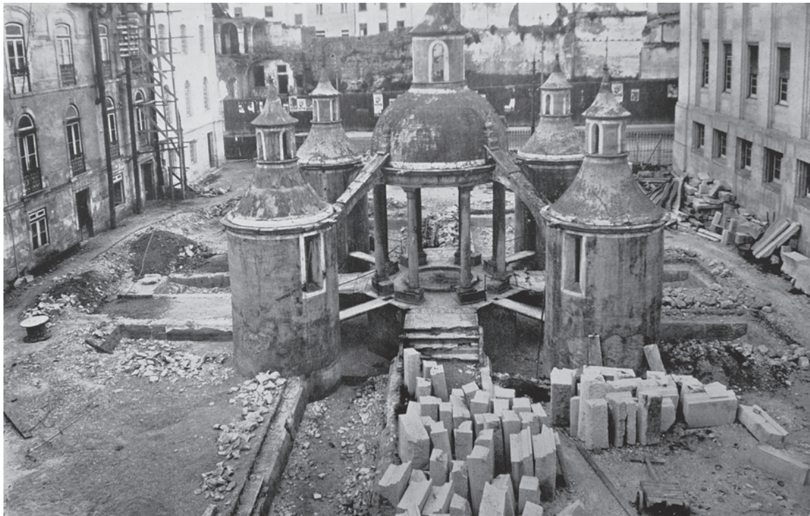
Fig. 88 - Intervenções da DGEMN na fonte da Manga, durante trabalhos de desobstrução dos tanques e preparação do restauro geral.
