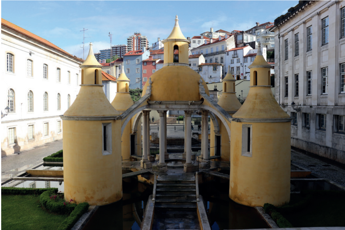
Fig. 74 - Fonte da Manga na atualidade; Vista a partir do presente terraço a sul do monumento.
