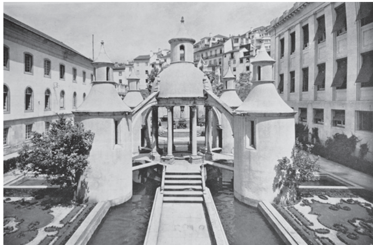
Fig. 92 - Fonte da Manga após os restauros por parte da DGEMN (vista para norte).
