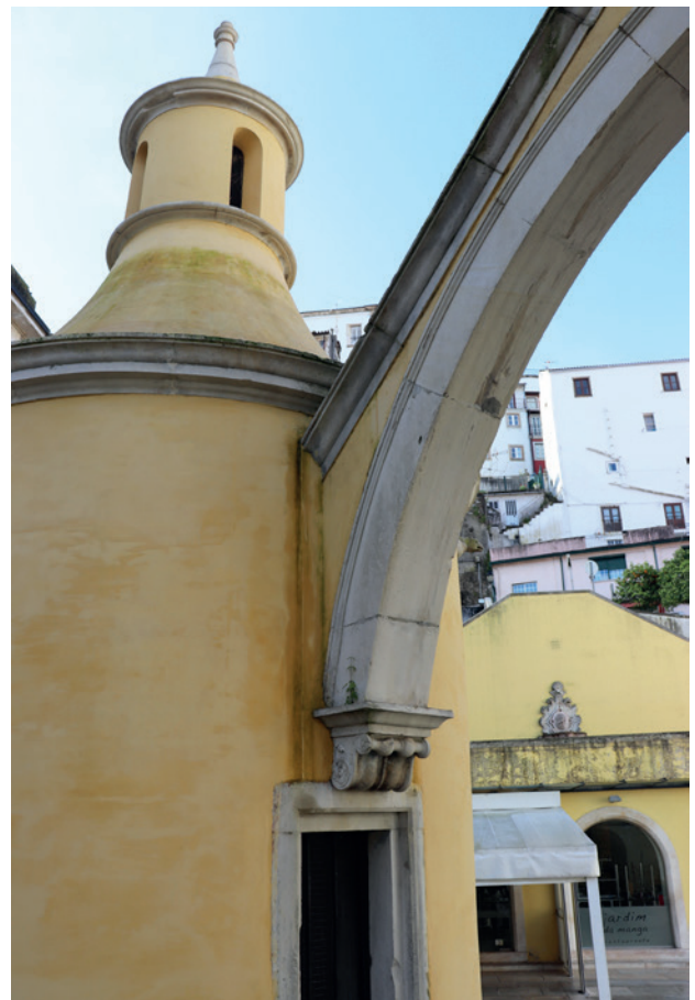
Fig. 114 - Fotografia atual de um dos cubelos da fonte e respetivo arcobante.
