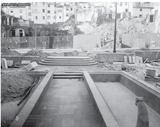
Fig. 90 - Intervenções da DGEMN na fonte da Manga durante o seu restauro (vista para a rua Olímpio Nicolau Rui Fernandes).
