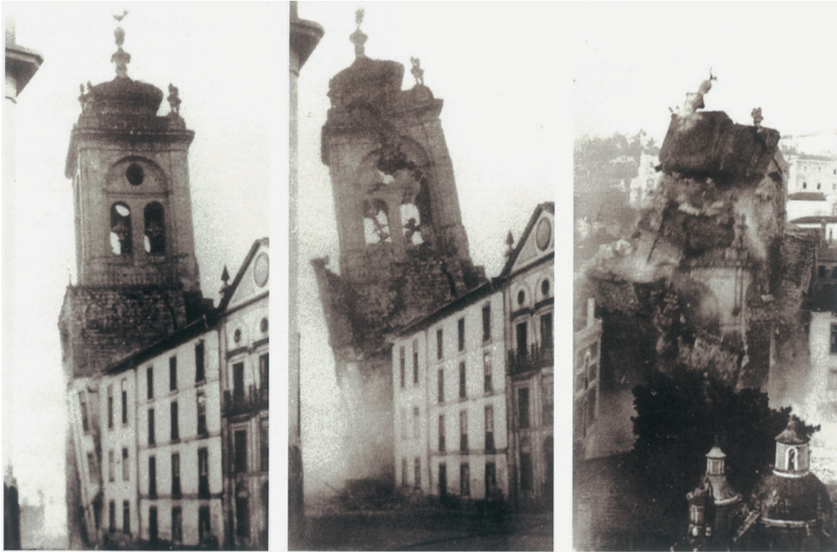
Fig. 83 - Torre de Santa Cruz no momento da sua derrocada, 1935.
