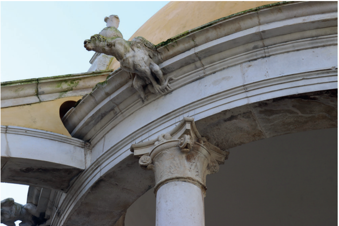
Fig. 119 - Pormenor do friso da cúpula central, com a ligação de um dos arcobotantes à cúpula, uma das gárgulas, e o capitel de uma das colunas.
