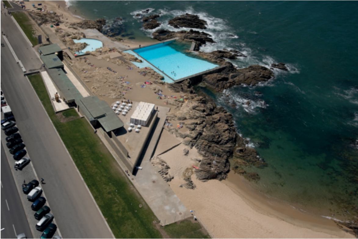
Fig. 190 - Vista aérea do complexo das Piscinas de Leça de Palmeira.
