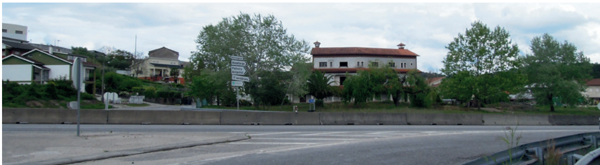
Fig. 195 - Atual estado do terreno (parte norte); vista a partir do lado oposto da via rodoviária IC2.
