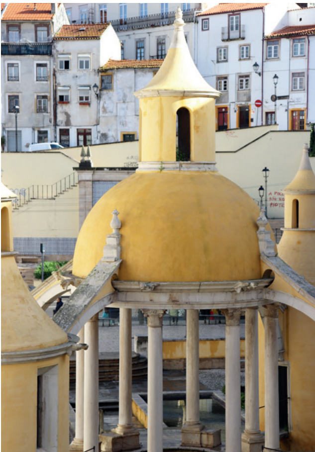
Fig. 113 - Fotografia atual da cúpula da fonte.
