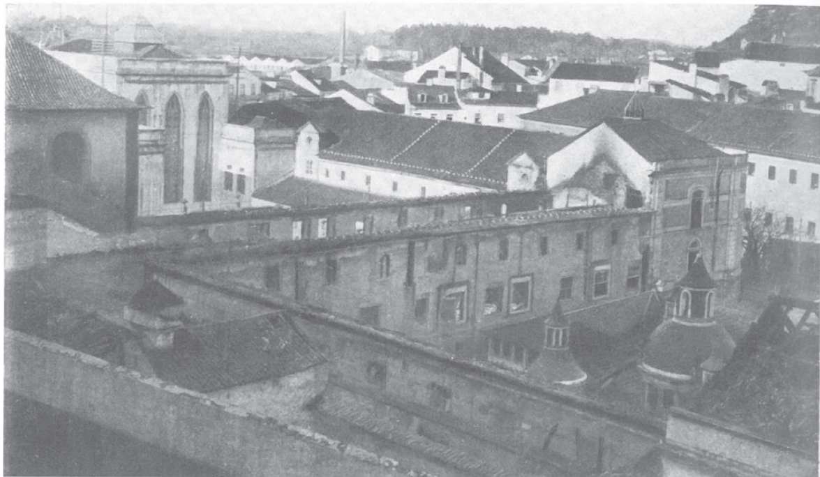
Fig. 108 - Claustro da Manga, visto de sudeste, depois dos incêndios da Escola Avelar Brotero; Fotografia de 1917.
