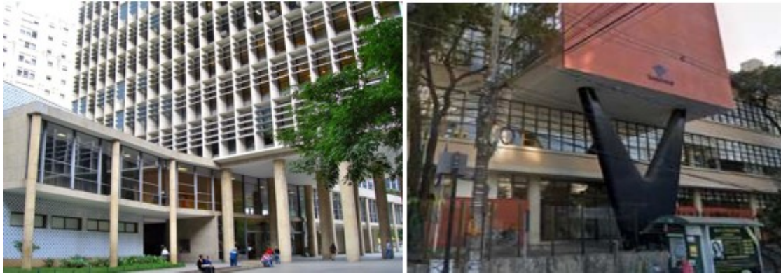
Figura 1.3 – Exemplos de edifícios com pilares externos. À direita, Palácio Gustavo Capanema (CAU/BR, 2018), na cidade do Rio de Janeiro e, à esquerda, edifício da Receita Federal do Brasil, na cidade de Belo Horizonte (Couri, 2015).
