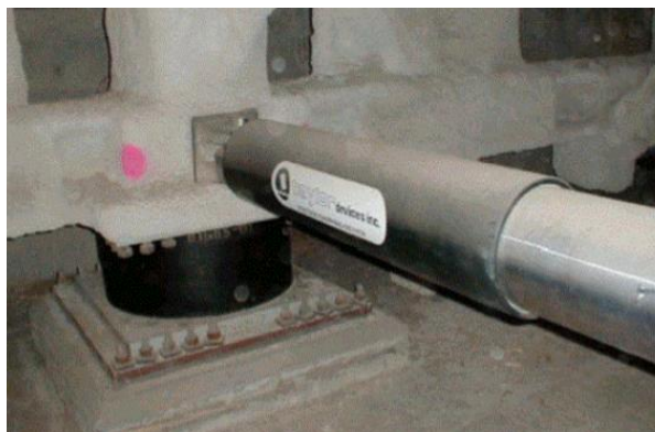
Figura 2.6- Blocos de apoio de borracha em associação com dissipadores (Guerreiro, 2009).
