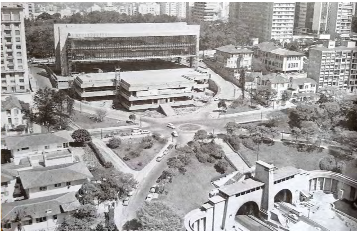
Figura 59 - O MASP no período final de sua construção e o túnel da avenida 9 de Julho. Imagem retirada de PISANI (2019, p.236).
