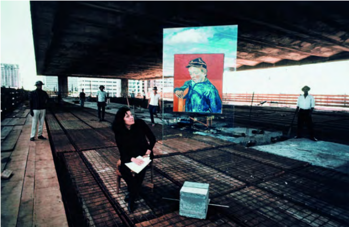
Figura 44 - Lina Bo Bardi no vão livre do MASP em obras. Fotografia de Lew Parella (1967).
