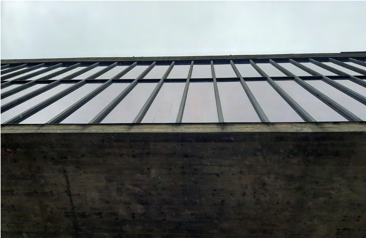
Figura 70 - Pormenor do alçado sul do MASP. Fotografia da autora (2020).
