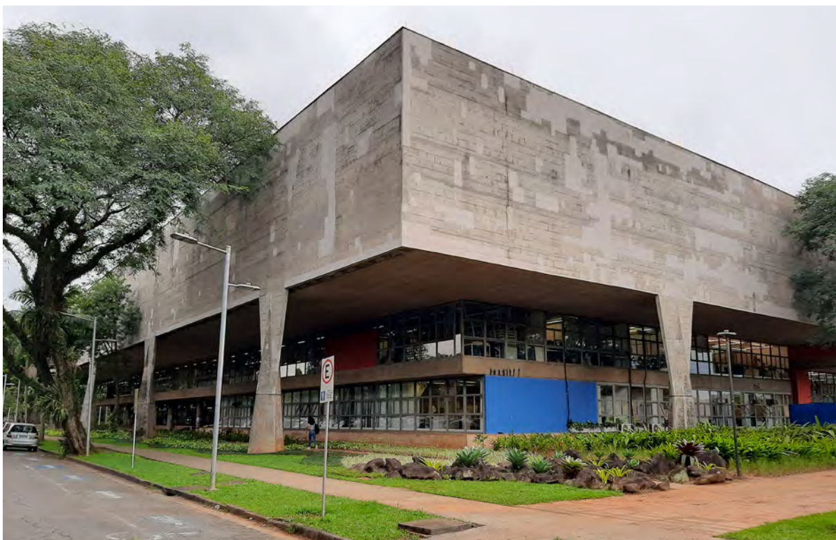
Figura 81 - Alçados sul e leste da FAUUSP a partir da rua do Lago. Fotografia da autora (2020).
