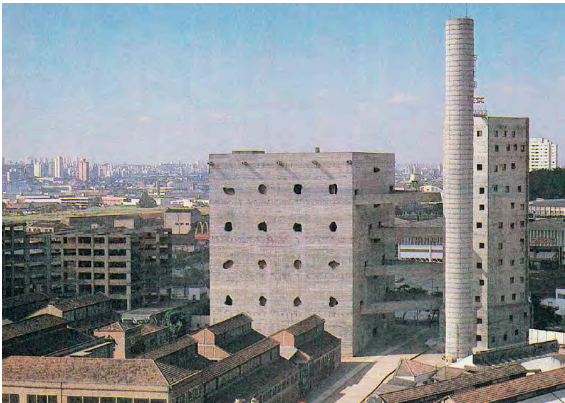
Figura 56 - O edifício do Sesc Pompeia de Lina Bo Bardi. Fotografia de Sérgio Gicovate (s/ data).
