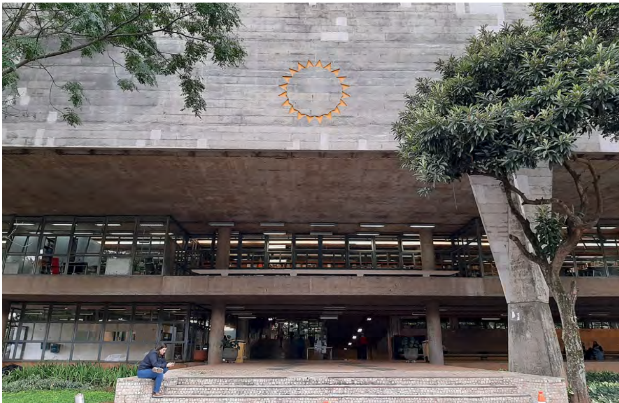
Figura 82 - Entrada da FAUUSP com as escadas de acesso. Fotografia da autora (2020).
