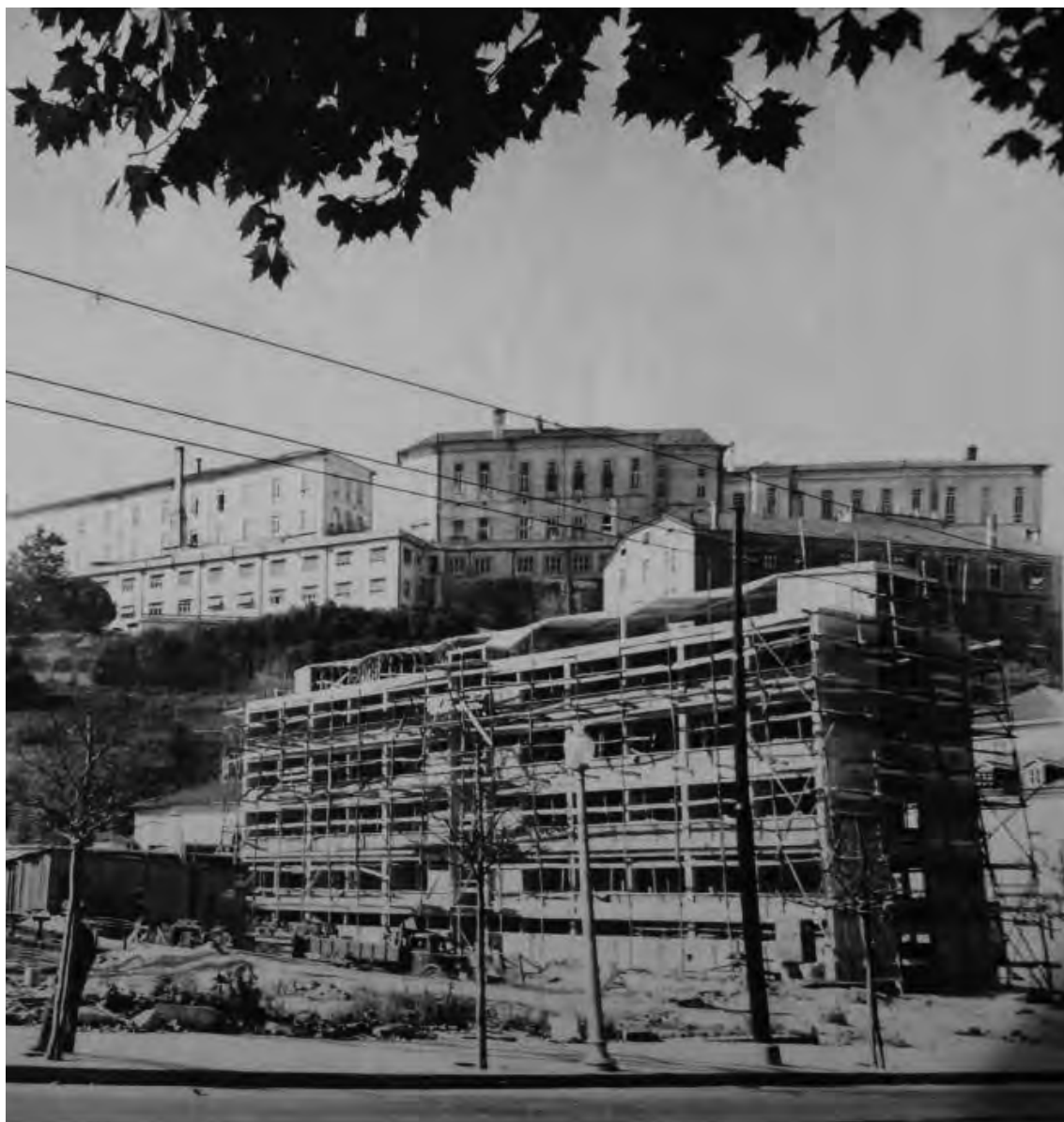
Fig. 3 - IAC em construção
