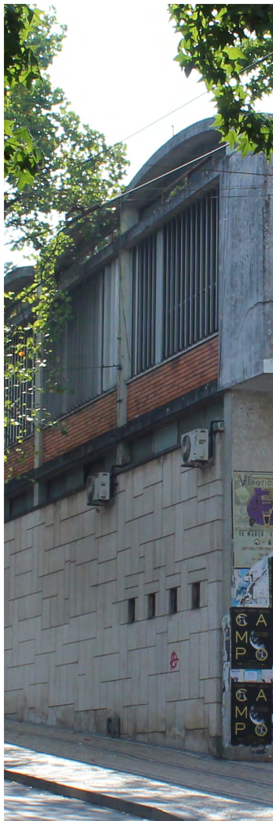
Fig. 51 - Fachada do Corpo III
