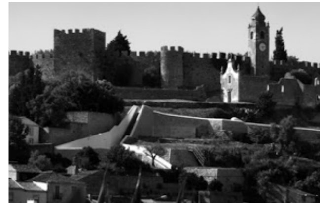
Fig. 198 - Escadas Rolantes de Montemor-o-Velho de Miguel Figueira
