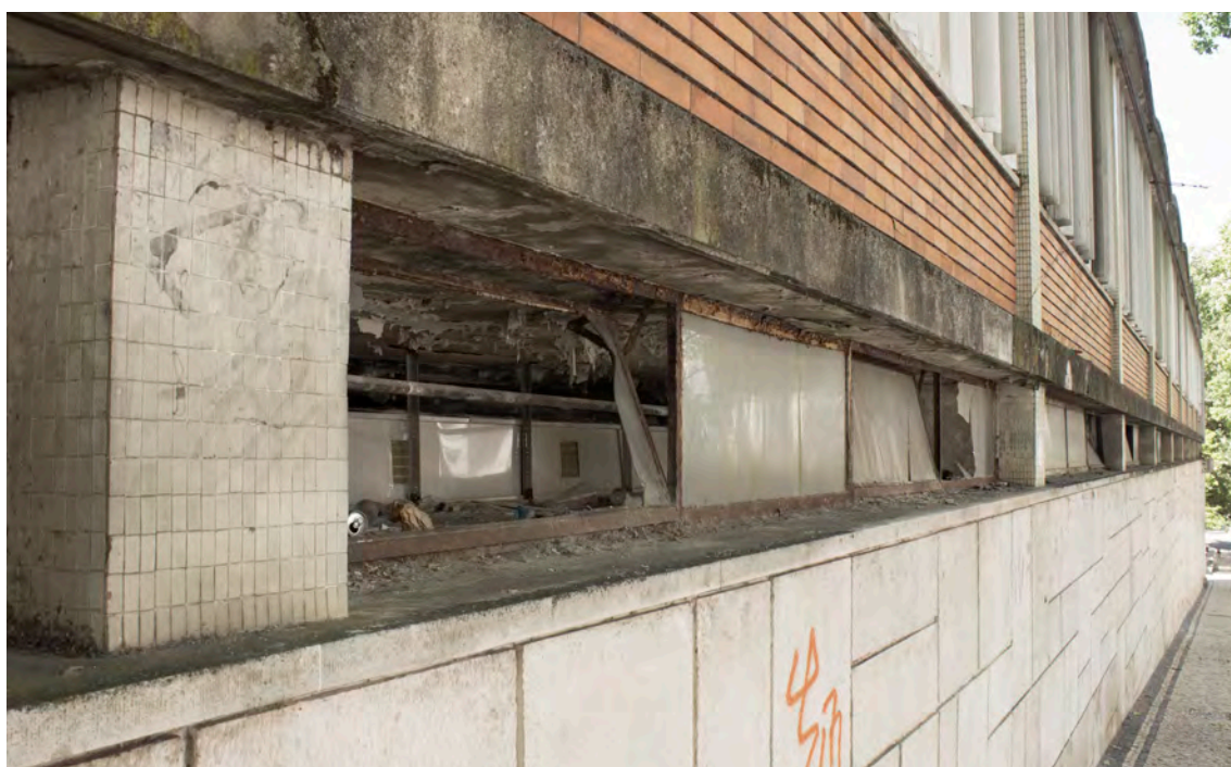
Fig. 54 - Fachada do Corpo III
