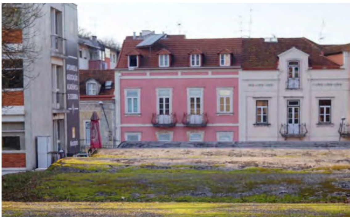
Fig. 52 - Cobertura do Corpo I
