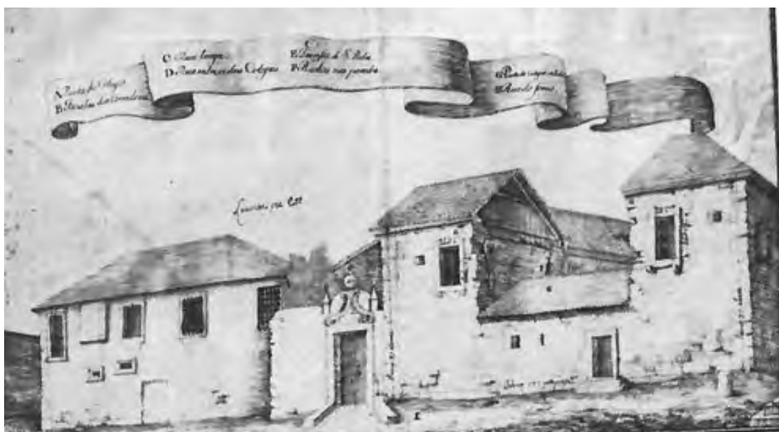
Fig. 7 - Fachada tardoz do Colégio de São Paulo, o Apóstolo
