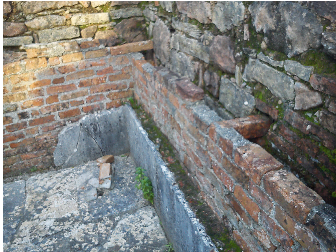
60. Caixa de ar e revestimento das paredes
