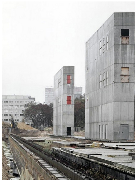
55. Topografia do Terror, construção das torres
