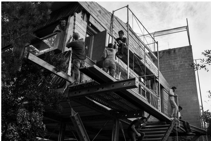
Figura 46: Autoconstrução das salas de aula "Tretzevents", Barcelona. 2013
