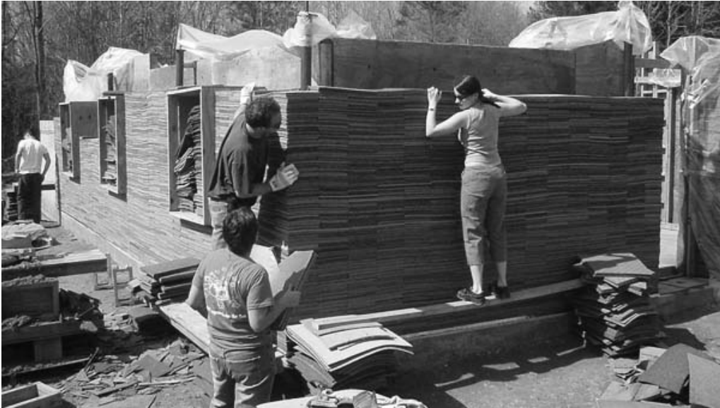
Figura 23: Construção da Casa Lucy, muro de carpete, 2002
