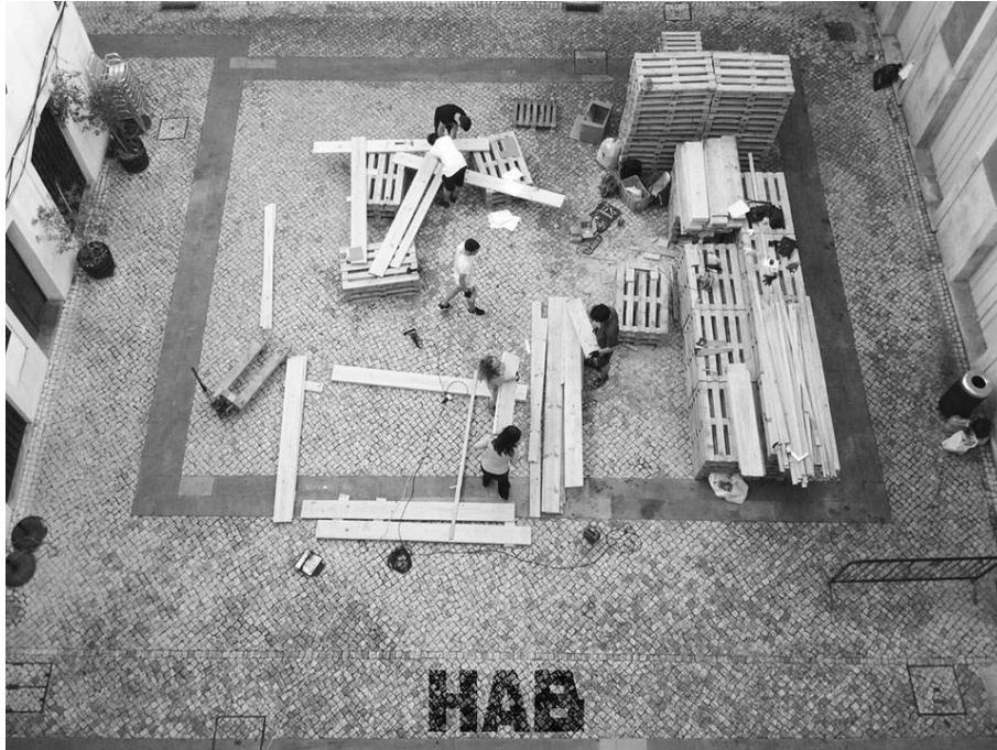
Figura 17: Construção de estruturas efémeras, 2017
