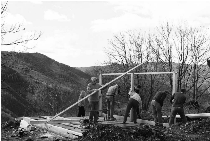
Figura 43: Construção de Les Bogues du Blat
