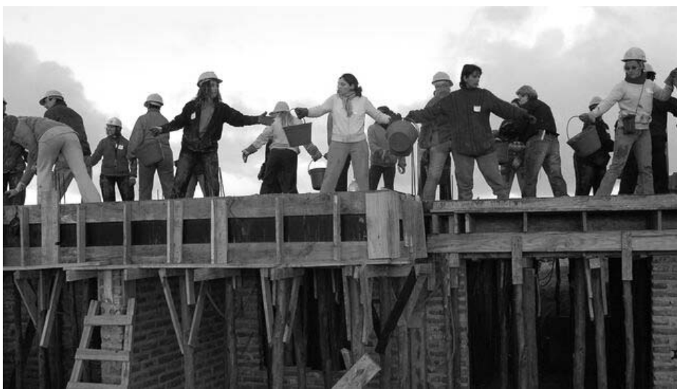
Figura 53: Processo de Autoconstrução promovido pela FUCVAM
