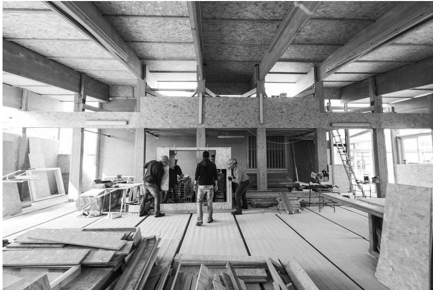
Figura 45: Autoconstrução Aula de Convivencia, Sevilha, 2017
