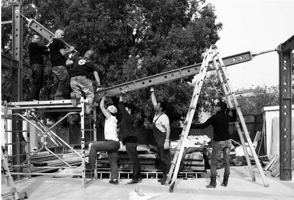
Figura 48: Autoconstrução das salas de aula "Tretzevents", Barcelona. 2013
