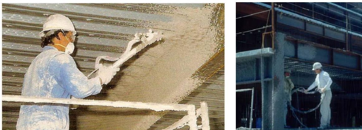
Figura 6.14 - Aplicação de argamassa projetada sobre estrutura de aço interna e externa. (GERKEN, 2007)
