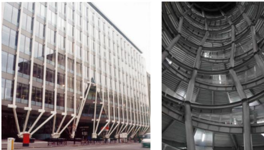
Figura 2.22 - À esquerda, Fleet Place House, em Londres e à direita Toulouse, Blagnax, França, estacionamento do aeroporto com pilares tubulares de aço preenchidos com concreto armado. (Fonte: https://www.steelconstruction.info/Fleet_Place_House,_London ; ESPINÓS e ROMERO, 2013)
