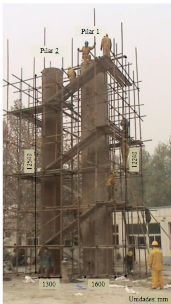
Figura 6.9 - Ensaio de concretagem em pilares em escala real. (adaptado de HAN et al. , 2014)
