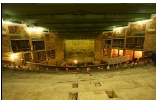
c) 2006 - Início da restauração
