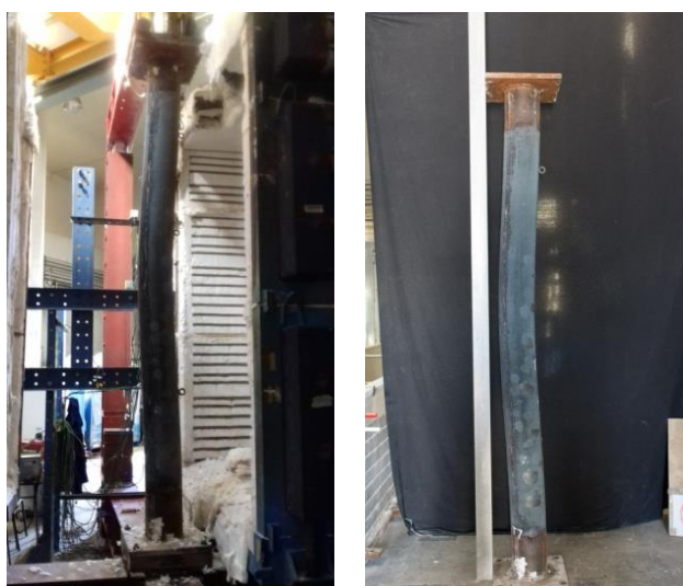
Figura 3.9 - Pilares após os ensaios.
