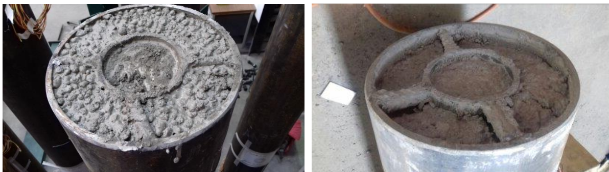
Figura 6.7 - Retração do concreto, à esquerda o pilar no dia seguinte à concretagem e à direita após 28 dias de cura do concreto.
