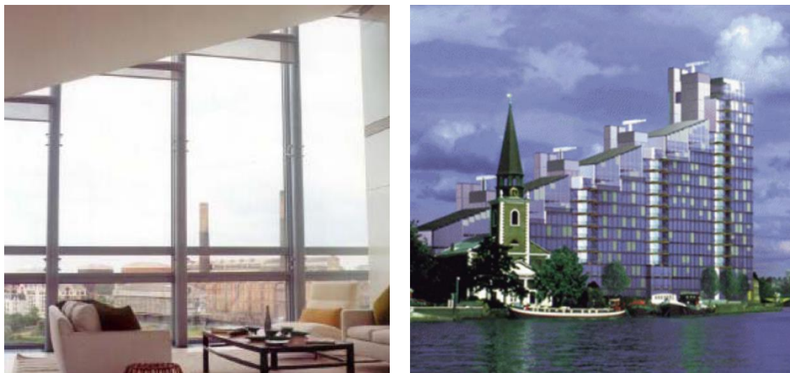
Figura 2.23 - Monteverto Apartments, Londres Edifício residencial de luxo com pilares em perfil circular de aço preenchido com concreto. (Fonte: ESPINÓS e ROMERO, 2013; https://www.steelconstruction.info/Monteverto_Apartments,_London ).
