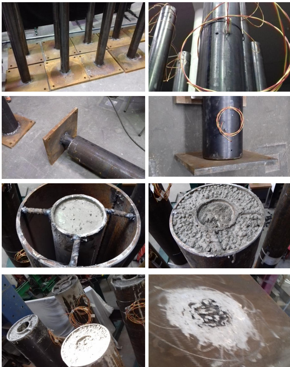
Figura 3.7 - Montagem e concretagem dos pilares.
