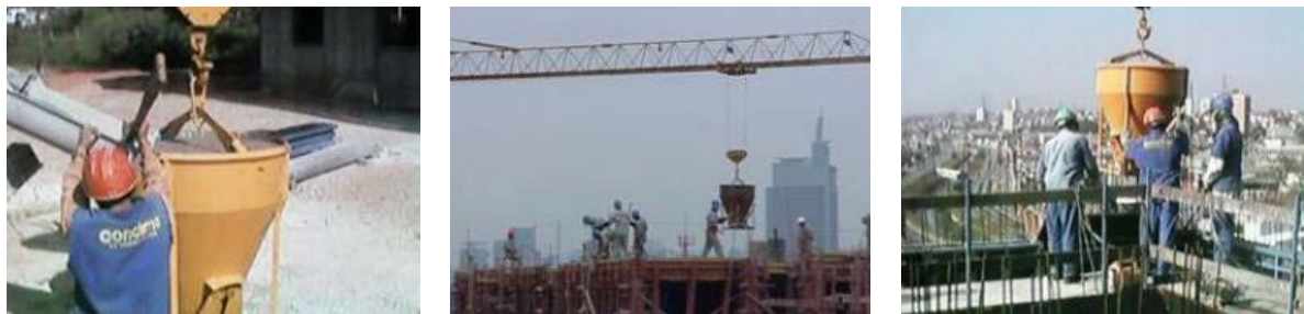
Figura 6.5 - Sistema de lançamento com grua e caçamba (funil). (Fonte: www.comunidadeconstrucao.com.br/sistemas-construtivos )
