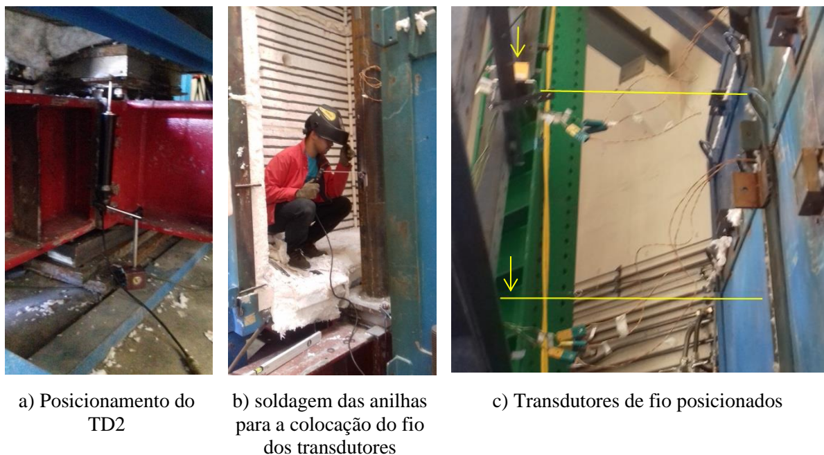
Figura 3.5 – Preparação dos pilares para os ensaios
