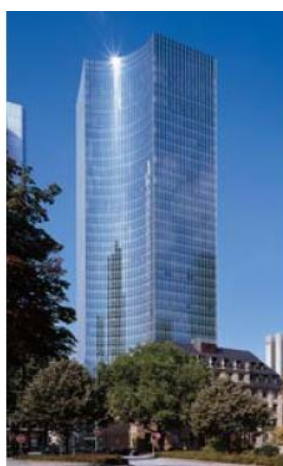
b) Edifício Skyper, Frankfurt, Alemanha
