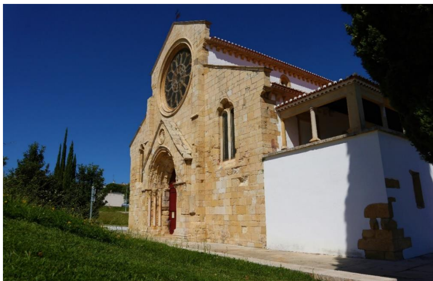
Fig. 1 Vista lateral da fachada da igreja de Stª Mª dos Olivais em Tomar, Santarém (foto cedida por Rodrigo Melo e tirada a 29.08.2019)
