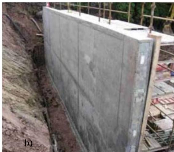
Figura 2.24 – a) - Muro de betão armados em L; b) - Muro de betão ciclópico, Pedro & Sousa (2018)
