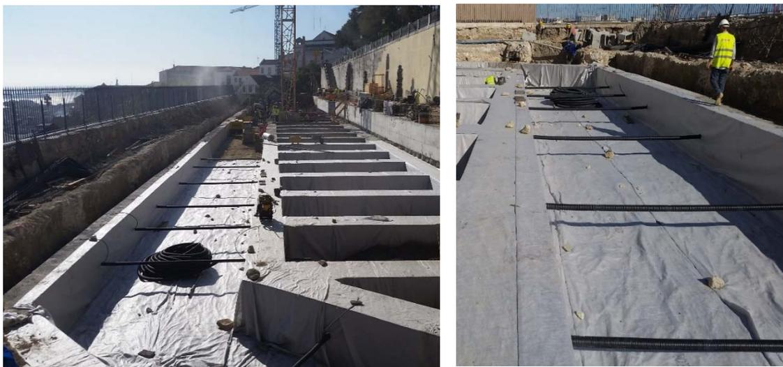
Figura 3.21 - Trabalhos de execução dos varões pré-esforçados, (Imagens capturadas pela JET<sub>SI</sub> 2017.).
