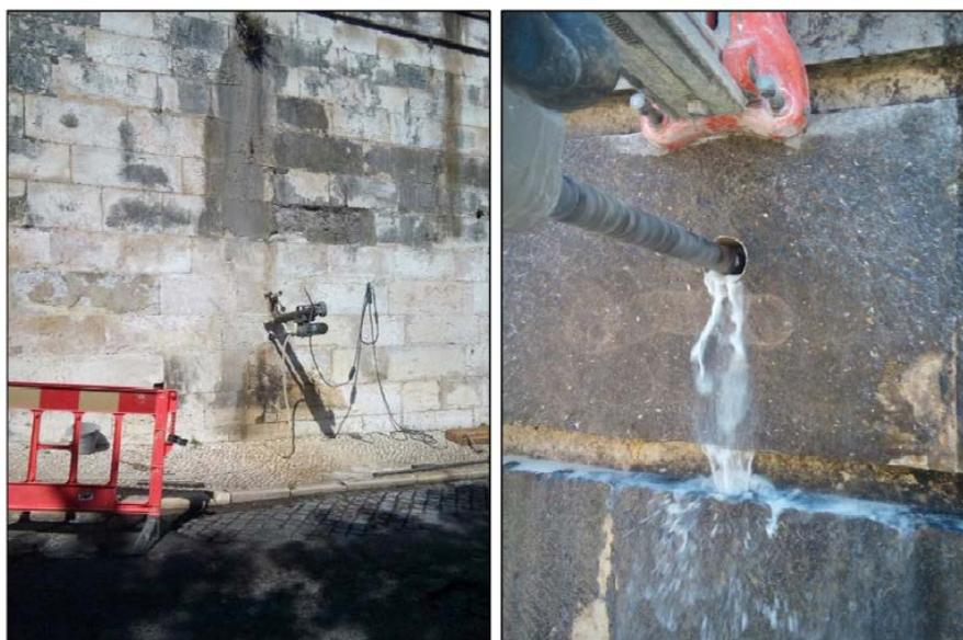
Figura 3.10 – Extração de testemunho (Geocontrole, 2016)
