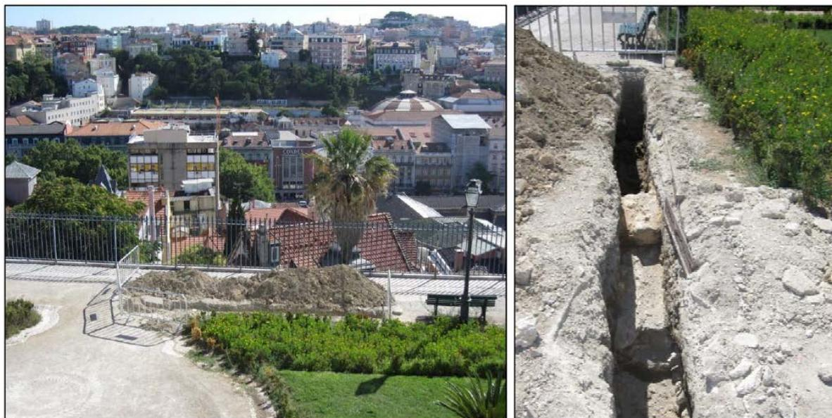
Figura 3.9 - Aspetto da abertura da vala de inspeção na plataforma inferior (Geocontrole, 2016).
