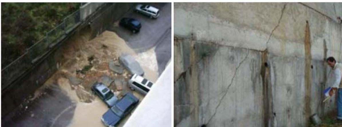
Figura 2.4 – Causas de uma drenagem insuficiente, (Pedro & Sousa, 2018)
