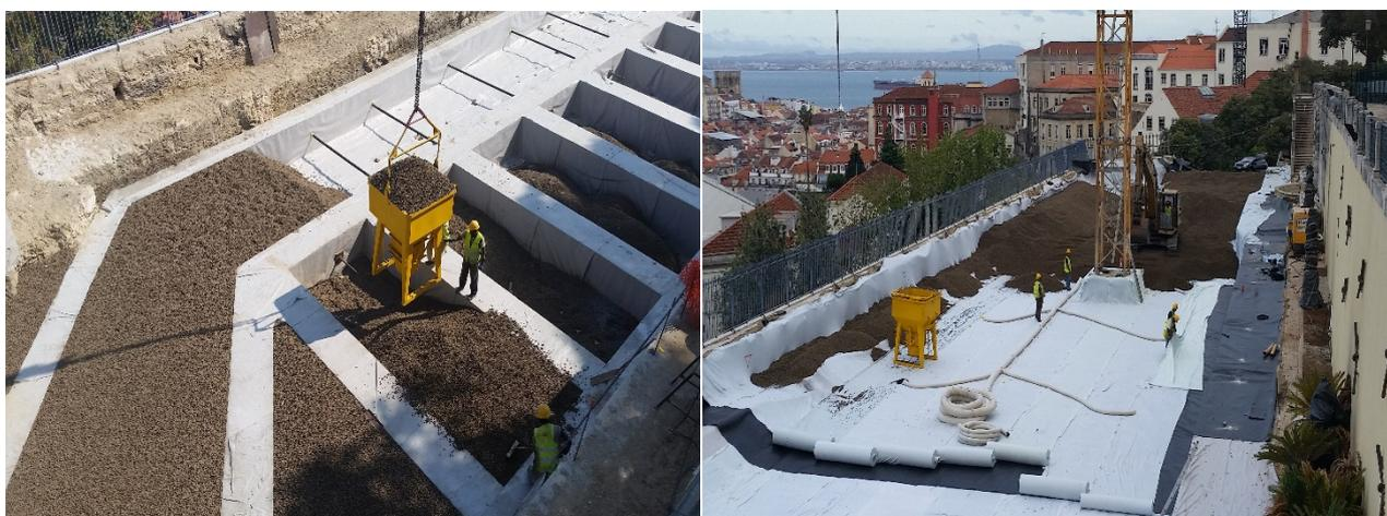
Figura 3.22 - Trabalhos de execução do aterro com agregado leve, (Imagens capturadas pela JET<sub>SI</sub> 2017.).
