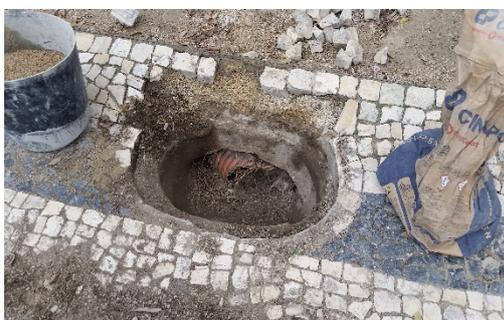
Figura 3.23 - Reabilitação dos sistemas de drenagem existentes, (Imagens capturadas pela JETSI)
