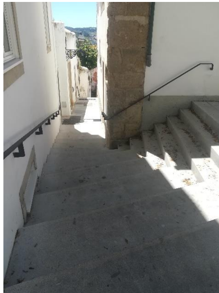
Figura 15: Entrada secundária do hotel, que dá acesso ao pátio das tias Camellas, após as obras. Fonte: Captura da autora a 25/05/2019.
