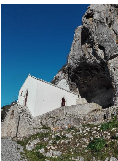
Figura 16: Capela da Nossa Sra. da Estrela Fonte própria (2018)
