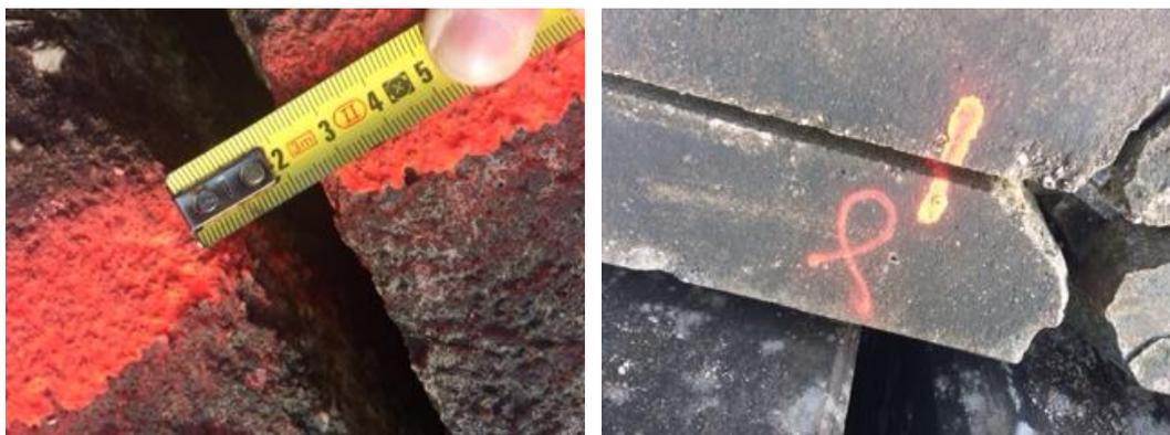
Figura 15 – Marcas no pavimento da cabeça do Molho Norte do Porto da Figueira da Foz.
