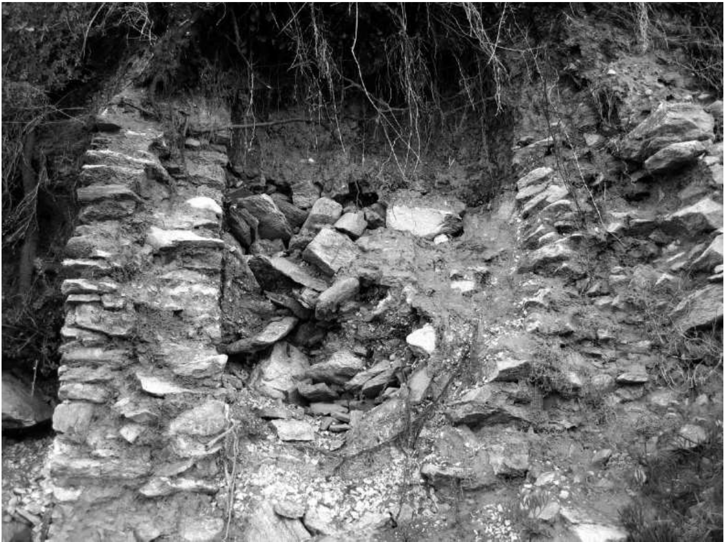
Figura 50: Detalhe dos muros de uma das pias ou tanque de salga.
