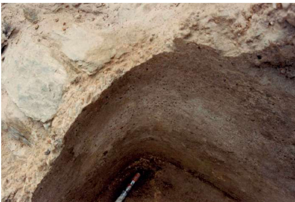
Figura 45: Detalhe do opus caementicium no revestimento do tanque de salga.
