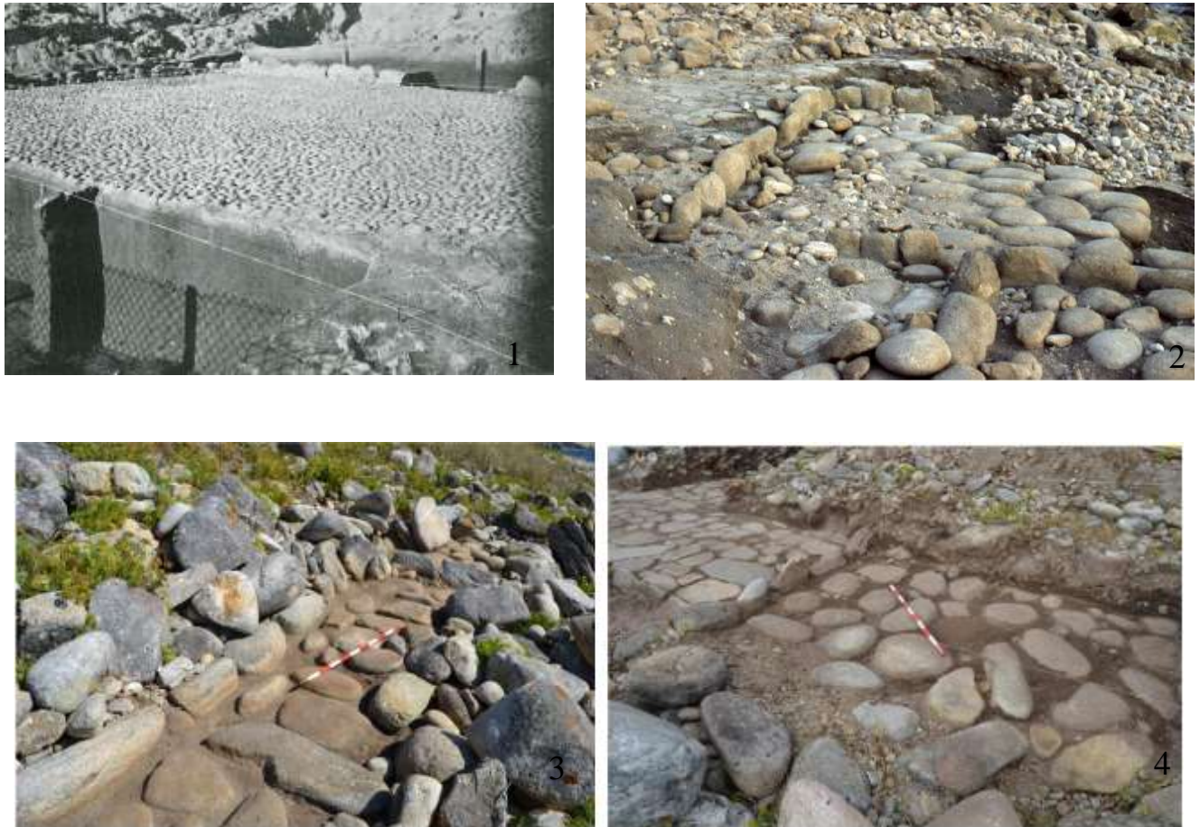
Figura 2: Exemplos de tanques de salinas que revelam um pavimento em seixos rolados intercalados com argila compactada. No caso das salinas de Lagoas (4) é possível identificar dois tipos de pavimento, um com seixos rolados, mais grosseiro, e outro com lajes horizontais muito regulares.
