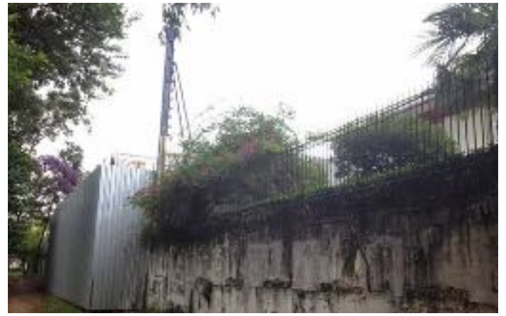
Figura 62: Vista do lado de dentro do Parque Ibirapuera com tapumes de obras das mansões do entorno em reforma invadindo o parque, além das cercas de segurança em arame farpado da casa vizinha; fotos da autora, jan. 2018
