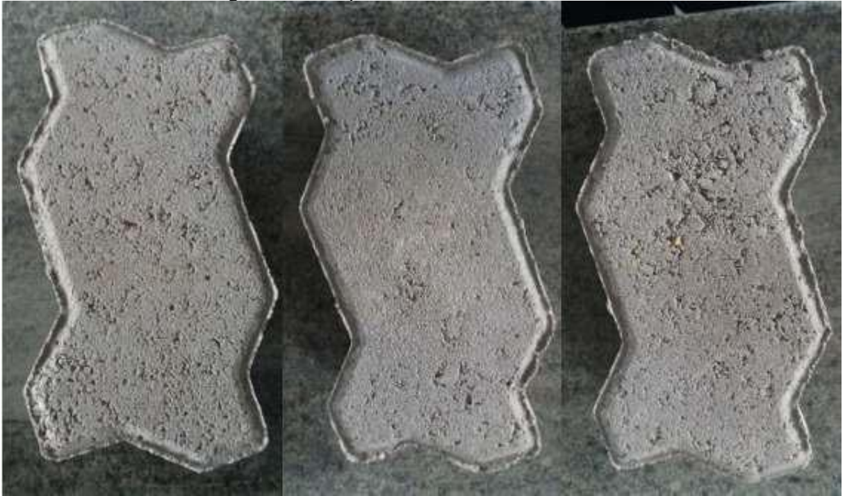
Figura 49 - Aspecto Visual dos Pavers P20
