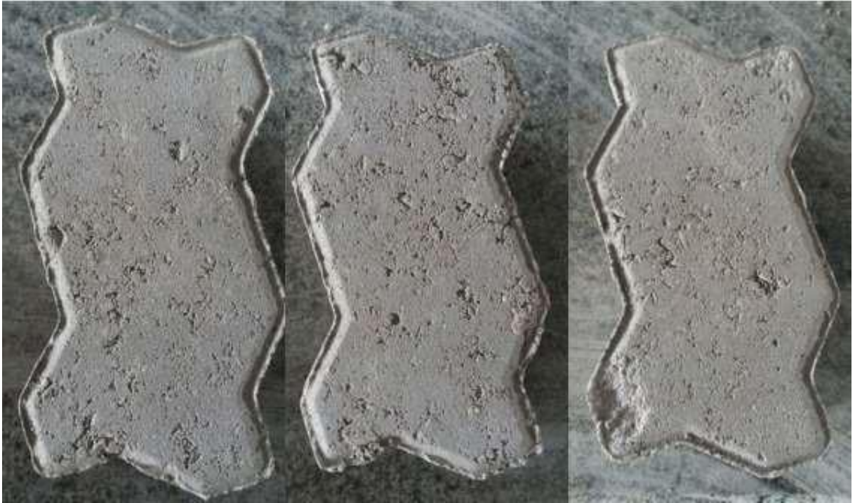
Figura 47 - Aspecto Visual dos Pavers Pref
