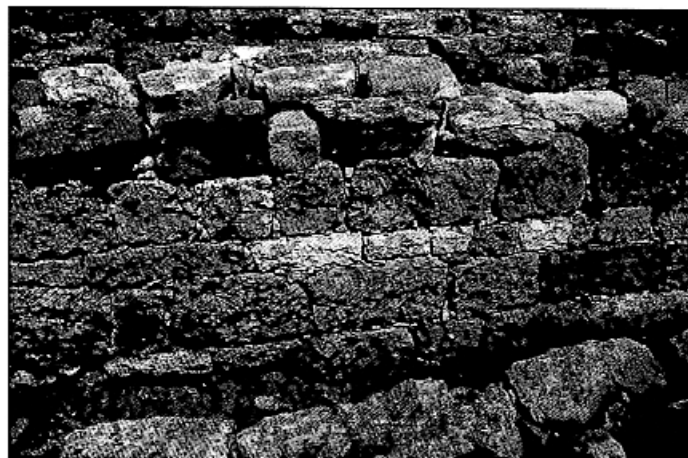
FIG. 6 - Foto de uma das paredes da segunda fase do celeiro
