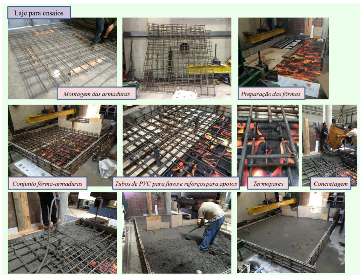
Figura 3.39 – Execução das armaduras e das fôrmas, instrumentação e concretagem da laje utilizada nos ensaios.
