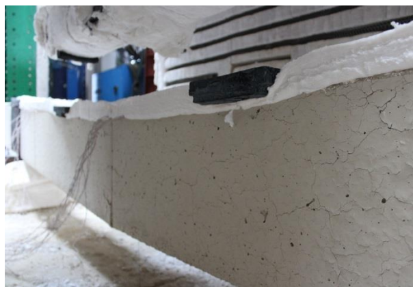
Figura F.3 – Detalhe da aparência “craquelada” da superfície de concreto após ensaio T_ka0_kr0_1.
