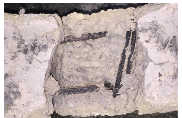
Figura F.38 – Detalhe da ruptura de uma armadura longitudinal superior na região próxima ao apoio simples, após ensaio ka2_kr1_2.
