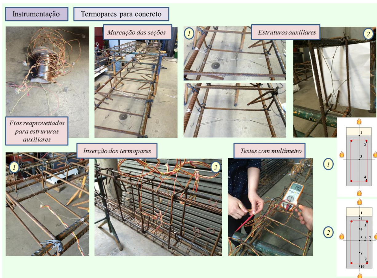
Figura 3.35 – Detalhes da instrumentação das vigas, com a inserção de fios de termopar para aferir as temperaturas em pontos do concreto.
