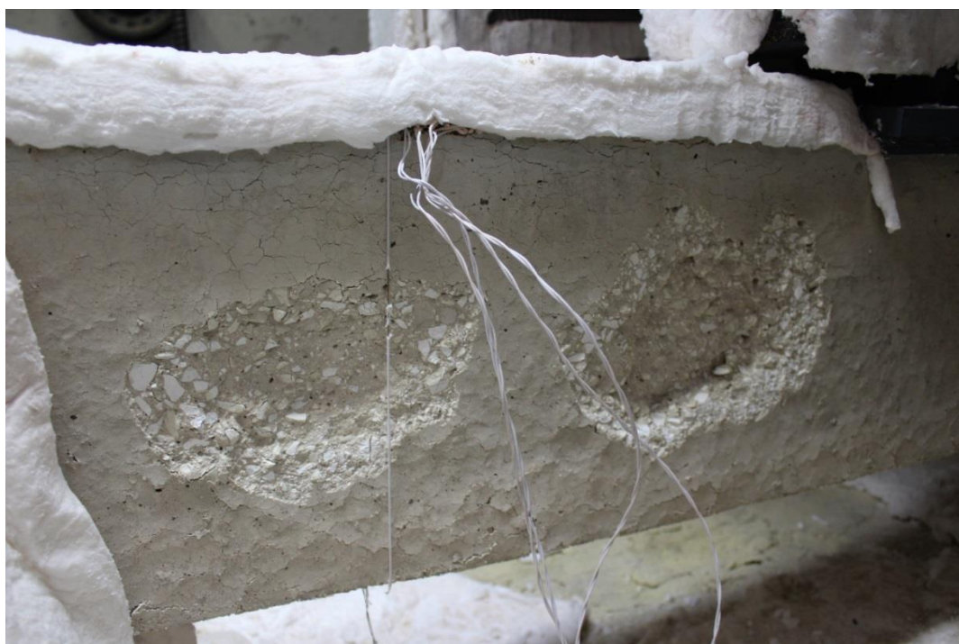
Figura 3.69 – Destacamento de pedaços de concreto na viga com restrição apenas axial do ensaio ka1_kr0_2.
