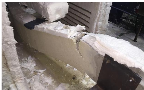
Figura F.28 – Instabilidade lateral com torção da viga após ensaio ka1_kr1_1.
