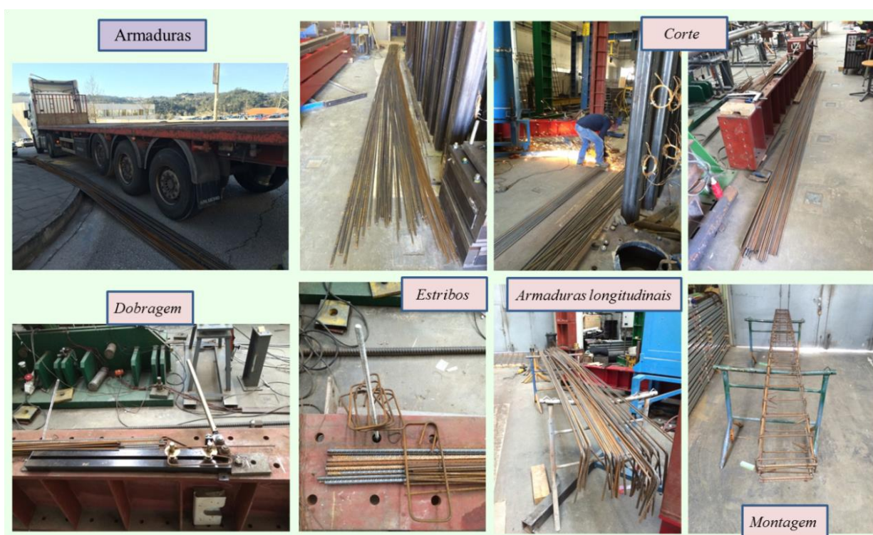
Figura 3.33 – Corte e dobragem das armaduras para produção das vigas.
