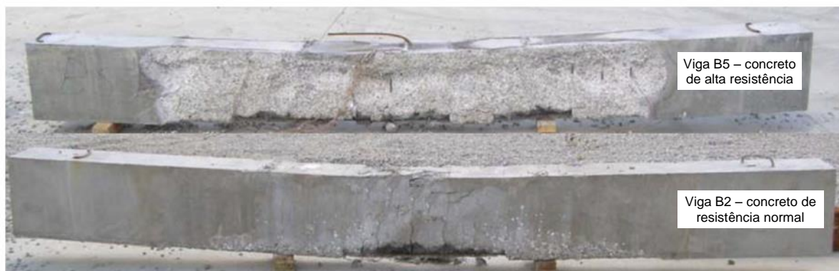
Figura 2.53 – Aspecto pós-incêndio de vigas de concreto com alta resistência, em que os efeitos de spalling foram marcantes, e com resistência normal (DWAIKAT; KODUR, 2009b; adaptado).
