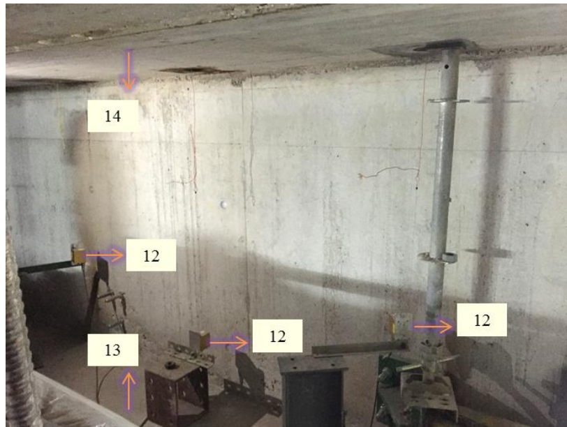
Legenda: 12. Transdutores de cabo para medição dos deslocamentos da viga de concreto; 13. Piso inferior do LEME; 14. Piso superior do LEME.
