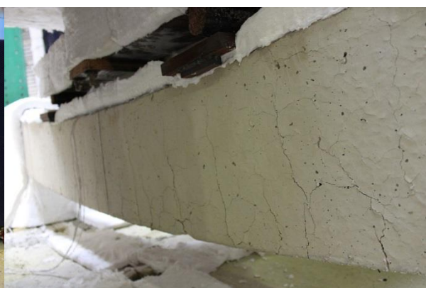
Figura F.11 – Detalhe da aparência “craquelada” da superfície de concreto e das fissuras de flexão após ensaio ka0_kr0_1.
