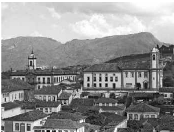
Figura 18 – Vista lateral da Capela do Carmo e frente da Casa de Câmara e Cadeia. Destaque para a elevação da Capela, com altos muramentos, em relação às construções vizinhas
