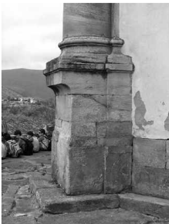
Figura 16 – Detalhe do pedestal da coluna ou contra-pilastra do frontispício
