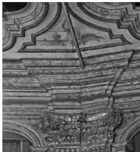
Figura 9 – Detalhe do capitel e da “linha de ferro”, saindo da cornija, que liga as duas “bandas” da talha que conforma a nave
