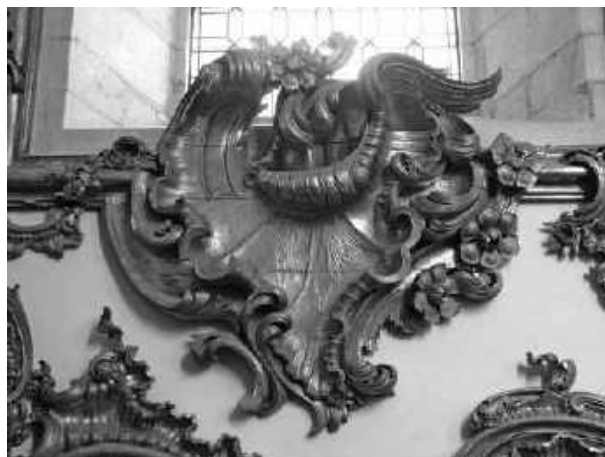
Figura 46 – Asas na moldura dos janelões da capela-mor da Igreja de São Martinho do Mosteiro Beneditino de Tibães, Braga, Portugal
