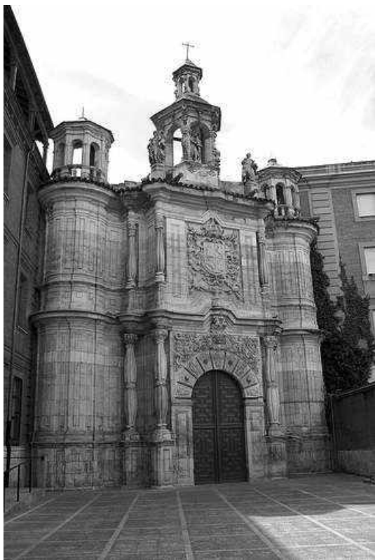
Figura 60 – Igreja de São João de Latrão, Valladolid, Espanha. Fonte: < http://flickr.com/photos/pedroarroyo/221064349/ >
