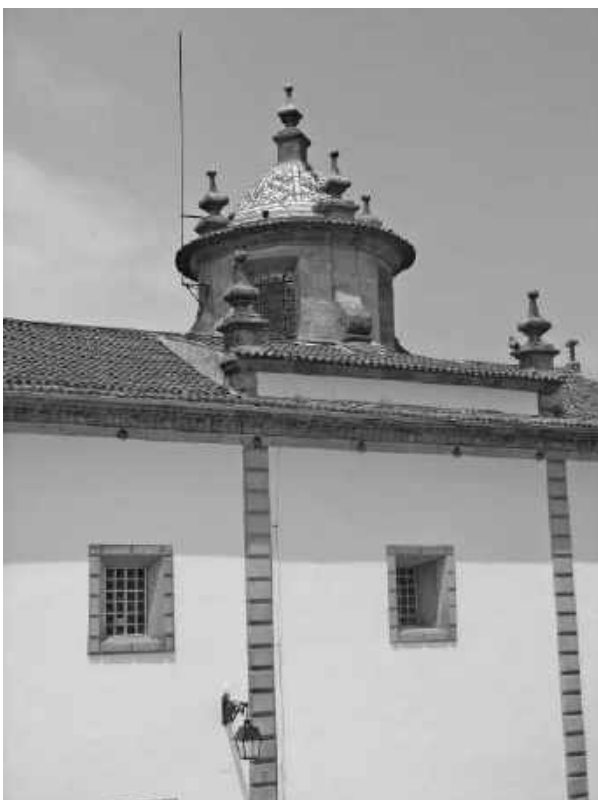
Figura 33 – Vista externa do zimbório da Igreja da Misericórdia, Viana do Castelo
