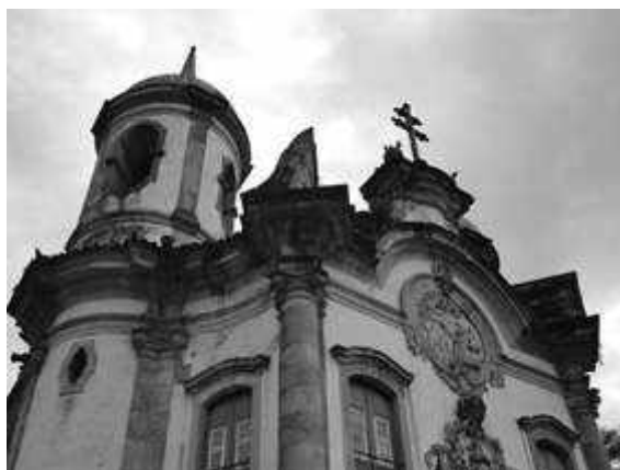
Figura 15 – Vista externa, com destaque para distinção de pilastras e contra-pilastras (colunas) do frontispício
