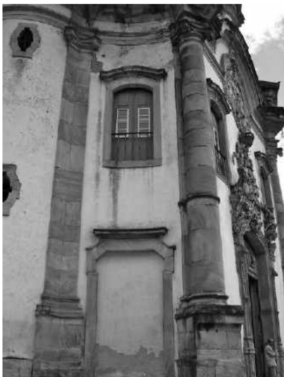
Figura 53 – Vista lateral das paredes côncavas que fazem articulação entre as torres e o frontispício
