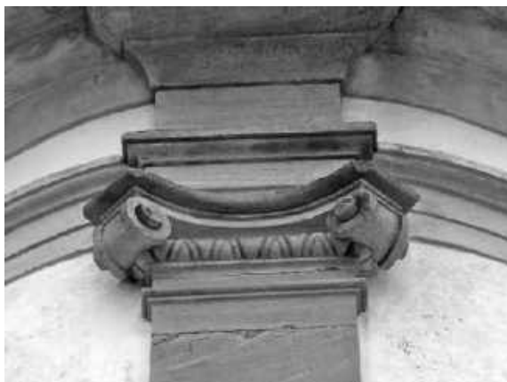
Figura 54 – Detalhe de capitel de pilastras na torre sineira
