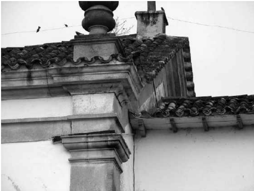
Figura 19 – Detalhe exterior da transição entre os corpos da nave e da capela-mor da Matriz de Santo Antônio, Casa Branca. Destaque para a humilde cachorrada que arremata as paredes da capela-mor, em contraste com a cimalha da nave em cantaria
