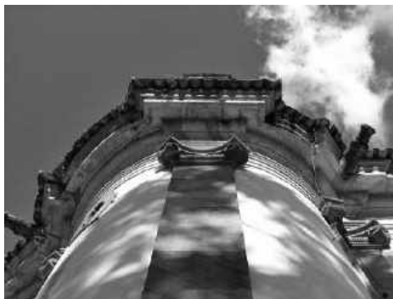
Figura 14 – Pilastras no volteio das torres sineiras
