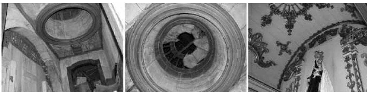
Figura 10 – Vistas do pequeno zimbório e do camarim do retábulo-mor da Capela do Carmo, Vila Rica
