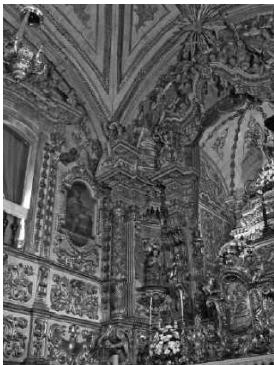
Figura 24 – Detalhe da parede da capela-mor, lado do Evangelho, e parte do retábulo, com destaque para as colunas salomônicas no primeiro registro lateral
