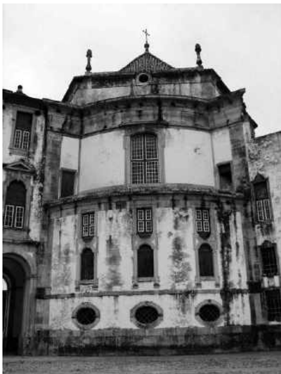
Figura 7 – Varandas da Igreja do Senhor da Pedra, Óbidos, Portugal. Risco do Arquiteto dos Ordens Militares, Rodrigo Franco
