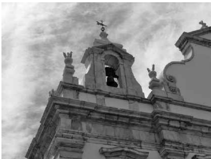
Figura 23 – Detalhe da fachada da Igreja da Misericórdia de Leiria, Portugal
