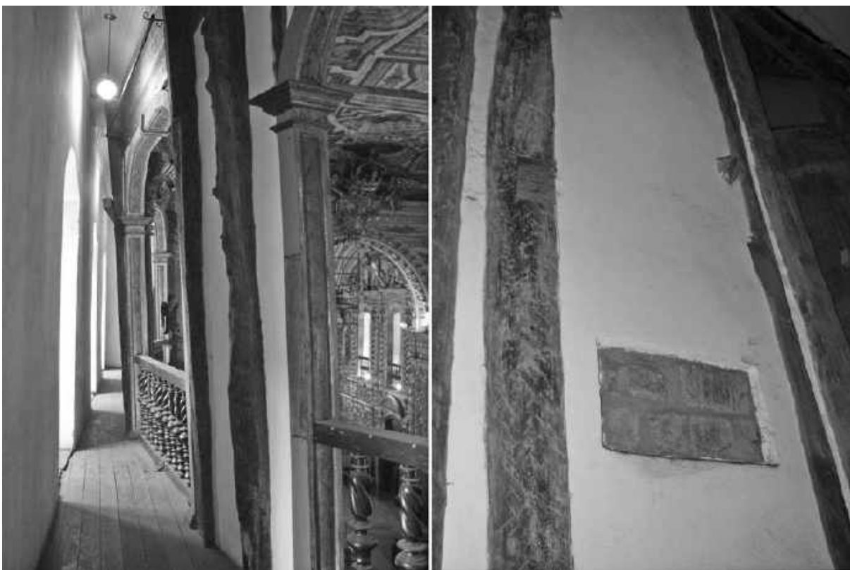
Figura 10 – Paredes de adobe que reforçam a estrutura de talha da nave
