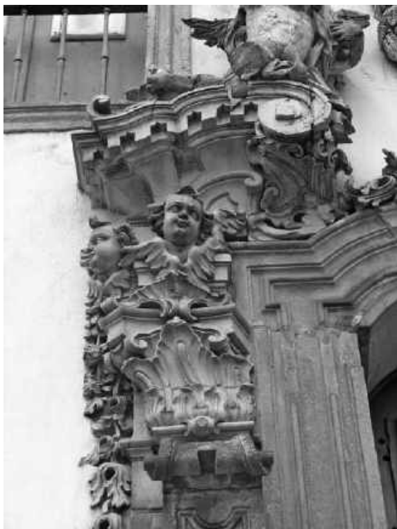
Figura 38 – Detalhe da ombreira e entablamento interrompido da portada
