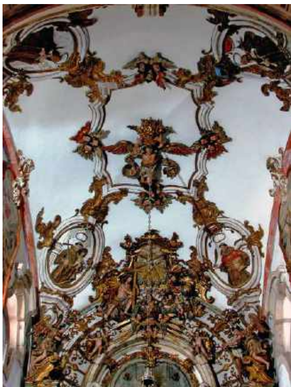
Figura 104 – Vista do coroamento do retábulo e forro da capela-mor, com medalhões contendo quatro santos da Ordem
