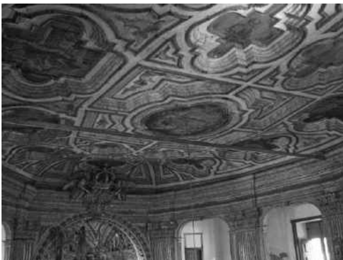
Figura 4 – Parte do forro da nave e “pé-direito” da Epístola. Atentar para a “linha de ferro”
