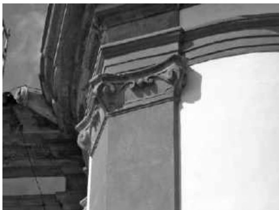
Figura 43 – Detalhe dos capitéis das pilastras das torres e frontispício
