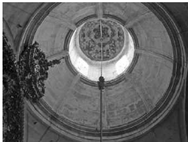
Figura 32 – Vista interna da abóbada e zimbório oitavado, com as quatro aberturas intercaladas a quatro paredes. Igreja da Misericórdia, Viana do Castelo
