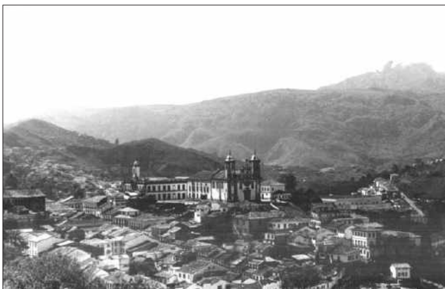
Figura 17 – Vista geral do Arraial de Pilar, com a Capela do Carmo altaneira em relação a todas as demais edificações
