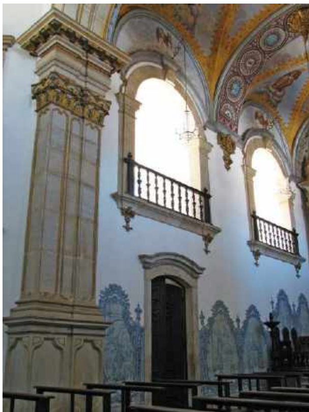
Figura 4 – Vista da parede lateral da capela-mor, lado do Evangelho. Atenção para a tribuna, a rica ornamentação arquitetônica do arco-cruzeiro e a barra de azulejos decorados
