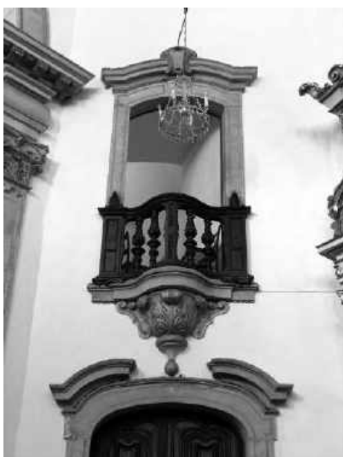
Figura 62 – Detalhe de porta-sacada e balaustrada da tribuna da capela-mor aberta no chanfro em direção à nave
