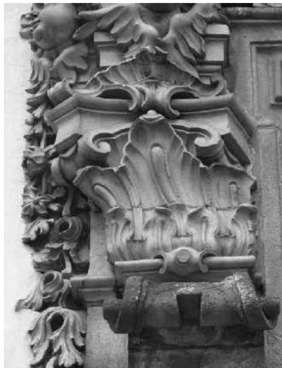
Figura 39 – Detalhe do capitel da ombreira da portada
