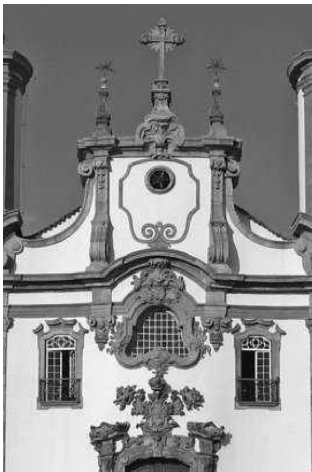
Figura 36 – Detalhe do frontispício do Carmo, empena da frontaria e repesas
