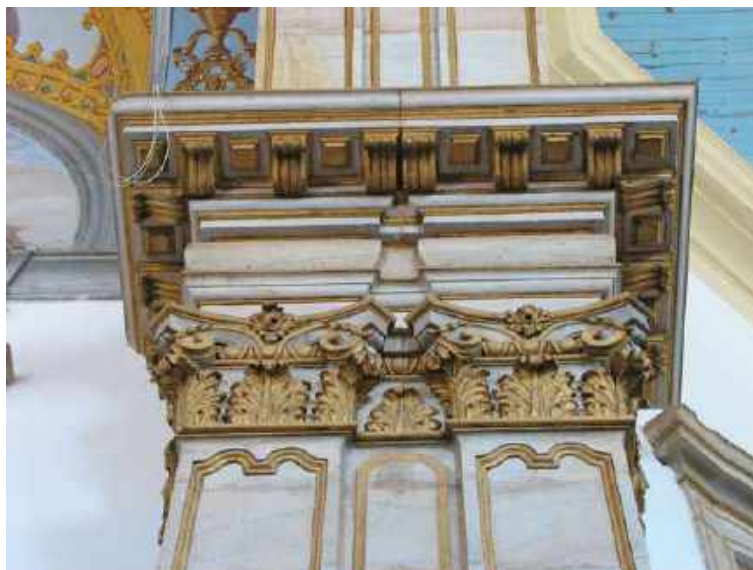
Figura 75 – Pilastras, capitéis e entablamento do arco-cruzeiro
