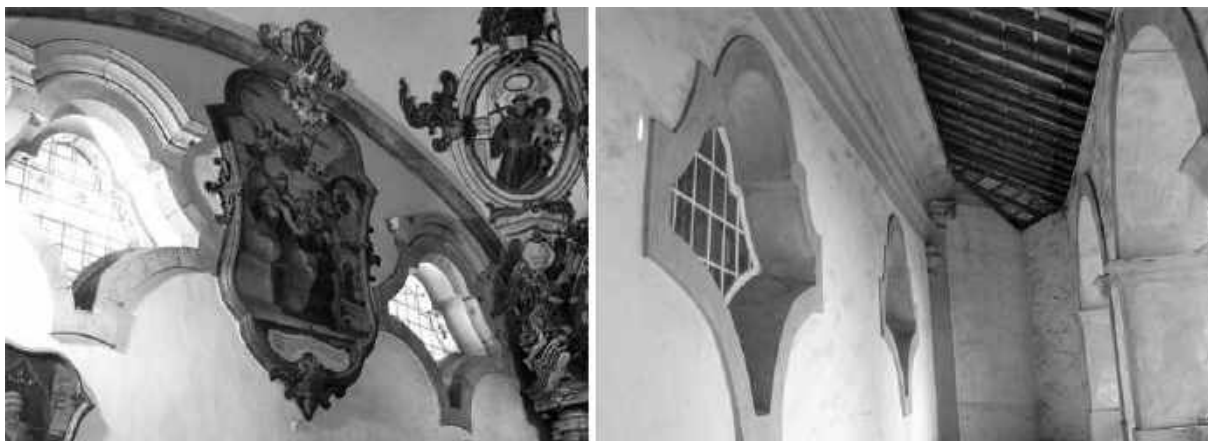
Figura 9 – Vistas, interna e externa, dos dois óculos da parede lateral da capela-mor
