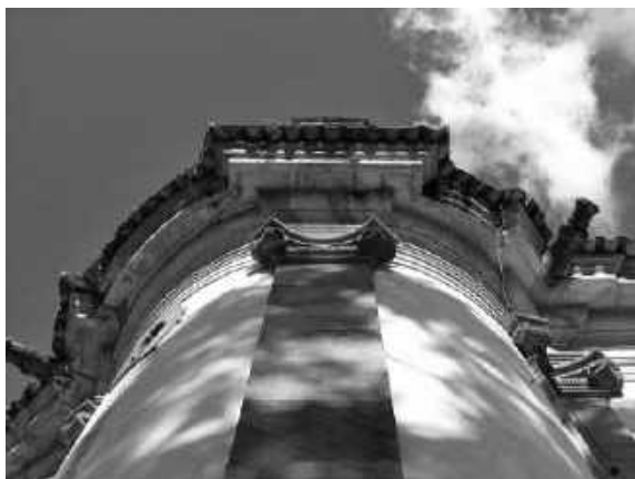
Figura 14 – Pilastras no volteio das torres sineiras. (Destaque para as duas gárgulas).
