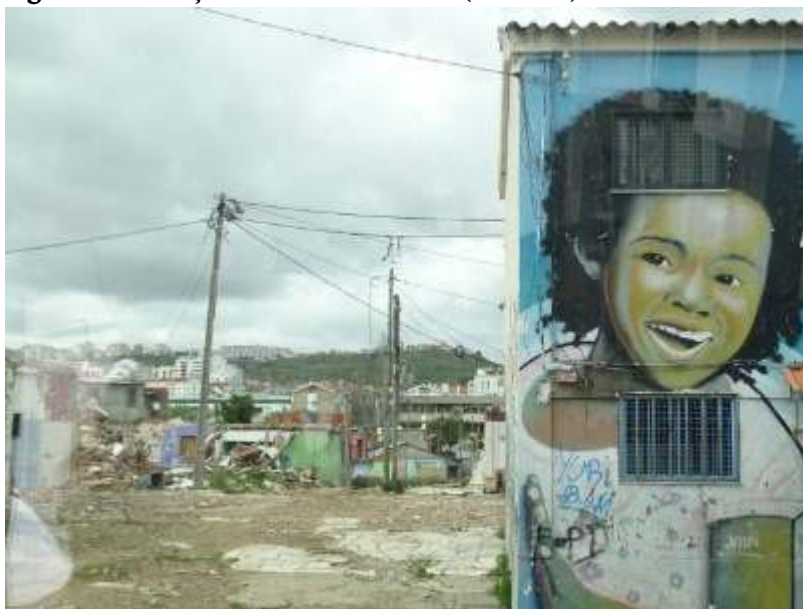
Figura 1. Demolições no bairro 6 de Maio (Amadora)
