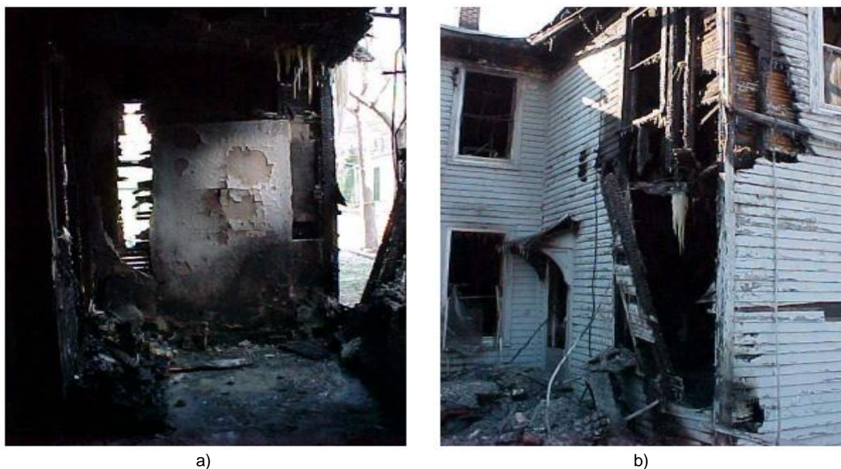
Figura 2.7. Cozinha depois do incêndio: a) interior da cozinha e b) vista traseira (adaptado de Madrzykowski, et al. 2002).
