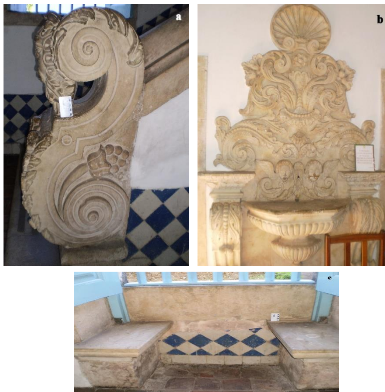
Foto 8.34 - Amostras de nichos com cantaria em calcário do Conjunto Franciscano. a) Escadas ornada com escultura de carranca; b) Lavatório; c) Assentos. Fotos: o autor.
