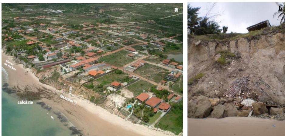
Foto 8.60 – Elementos da geodiversidade no LIG/LS 005. a) Vista aérea do Local de Interesse, com os afloramentos de calcário da Formação Maria Farinha na praia, os blocos de rocha no sopé das falésias ativas, o nível de provável sismo no arenito Barreiras e a ocupação intensa do topo dos tabuleiros. Foto: Ricardo Paulo; b) detalhe da queda de rochas, atingindo as edificações no topo. Foto: o autor.
