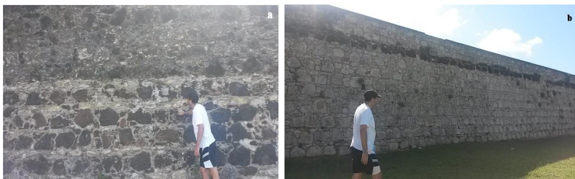
Foto 8.50 - Elementos da geodiversidade ex situ presentes na Fortaleza de Cabedelo. a) Parede composta basicamente de arenitos ferruginosos; b) Parede com blocos de calcário e uma linha superior com arenitos ferruginosos. Fotos: Ingridy Pereira.
