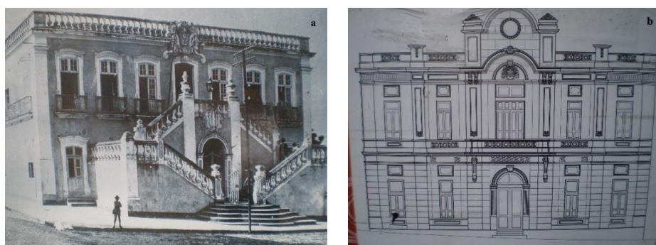
Figura 8.10 – Detalhes arquitetônicos da Casa dos Contos. a) Linhas arquitetônicas originais da Casa dos Contos, antes do incêndio de 1916. b) Linhas arquitetônicas atuais. Nota-se que a escada frontal foi retirada. Fotos: arquivo IPHAN.
