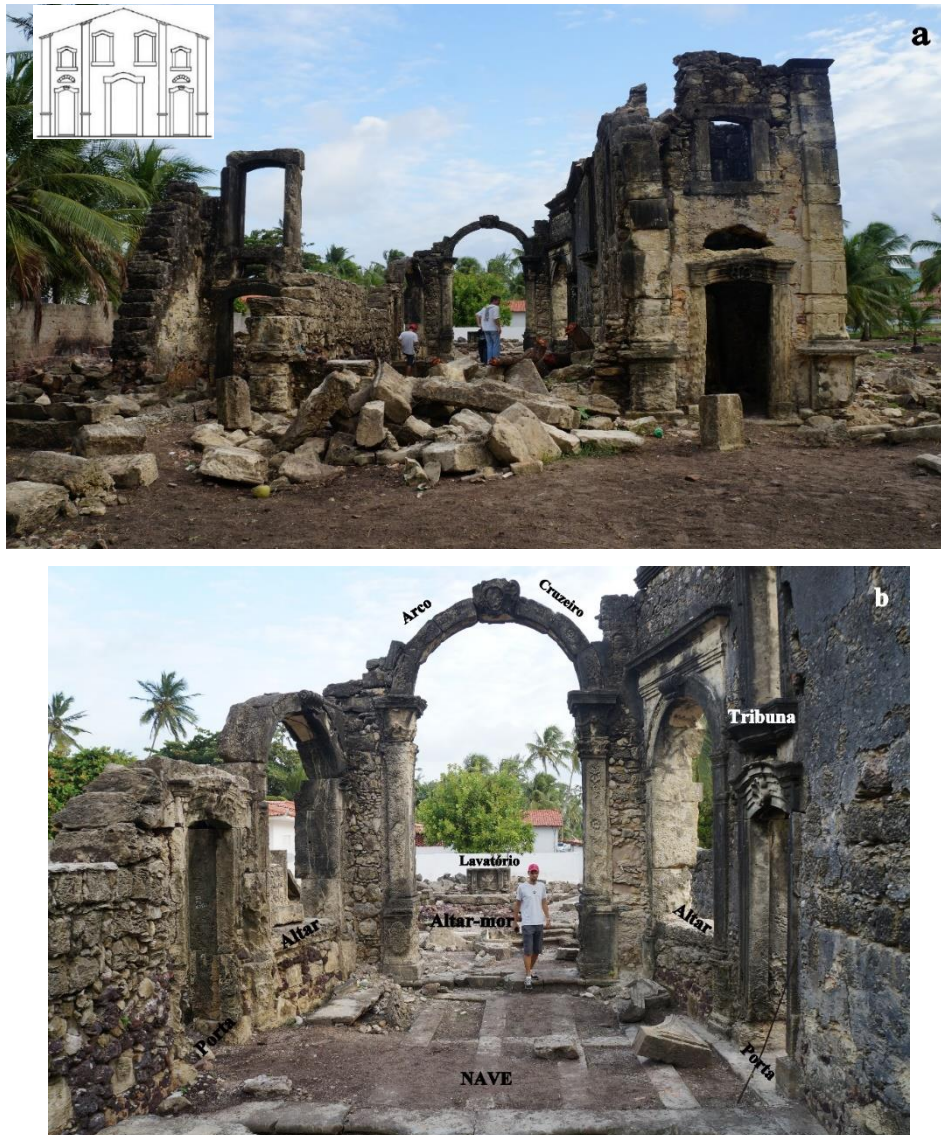
Foto 8.52 - Ruínas de Almagre. a) Vista da fachada frontal e, em detalhe, modelo da fachada completa. Nota-se que os cunhais da torre estão com risco de desabamento; b) Detalhe de alguns componentes internos da igreja. Fotos: o autor.
