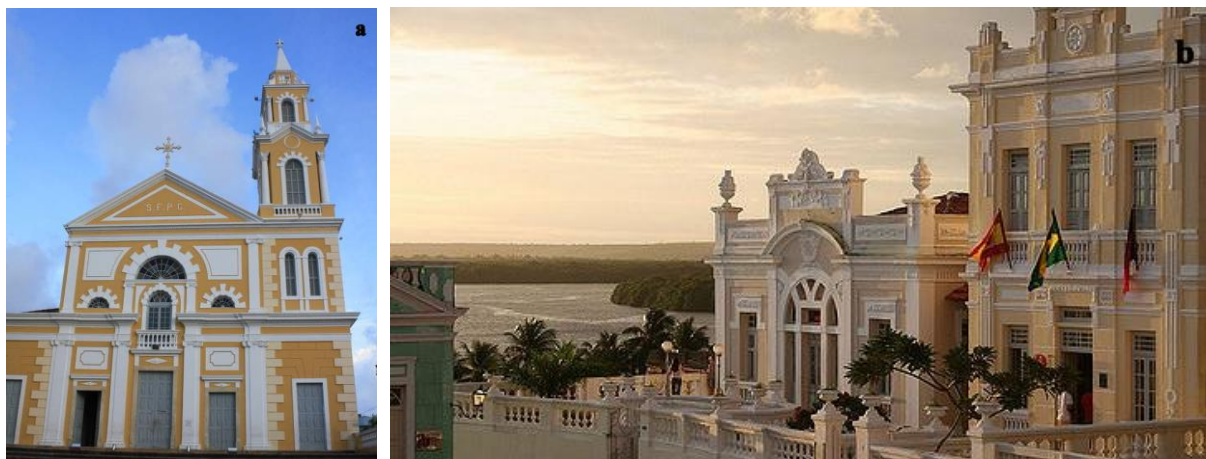
Foto 8.1 – Edificações no Largo de São Frei Pedro Gonçalves. a) Visão frontal da Igreja São Frei Pedro Gonçalves. Foto: o autor; b) Visão lateral do Hotel Globo e do prédio anexo, com o Rio Sanhauá ao fundo. Foto: Gilberto Stuckert.
