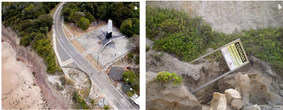
Foto 8.43– Situação atual da falésia de Cabo Branco. a) Foto aérea do farol do Cabo Branco, mostrando o desabamento de parte da falésia. Foto: Portal Correio; b) base da falésia, com placa advertindo a possibilidade de desmoronamento da área. Foto: o autor.
