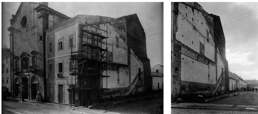
Fig. 51 – Execução da abertura de rua nova a norte da Igreja de São Domingos e perpendicular à Rua da Sofia. Referência: IHRU-SIPA, IPA.00002794 728 .
