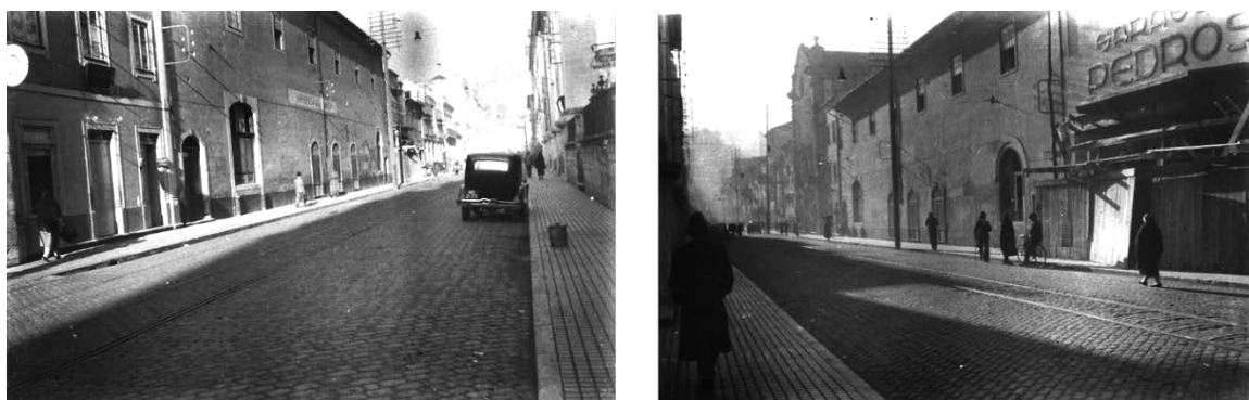
Fig. 48 – Rua da Sofia, antes da abertura da Rua João de Ruão: edifício de três pisos existente e demolido para se executar a abertura da nova rua. Fotografia: Coleção de José Andrade de Branquinho de Carvalho 719 .
