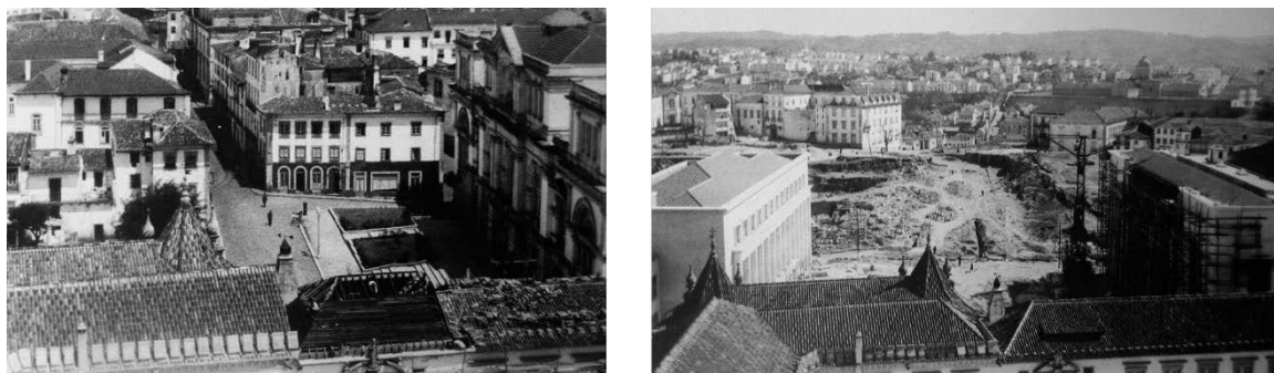
Fig. 18 – Demolições na Alta: vista sobre a Rua Larga, da Torre da UC, antes e depois das demolições para a construção da CUC. Fotografia: Associação dos Antigos Estudantes de Coimbra 410 .
