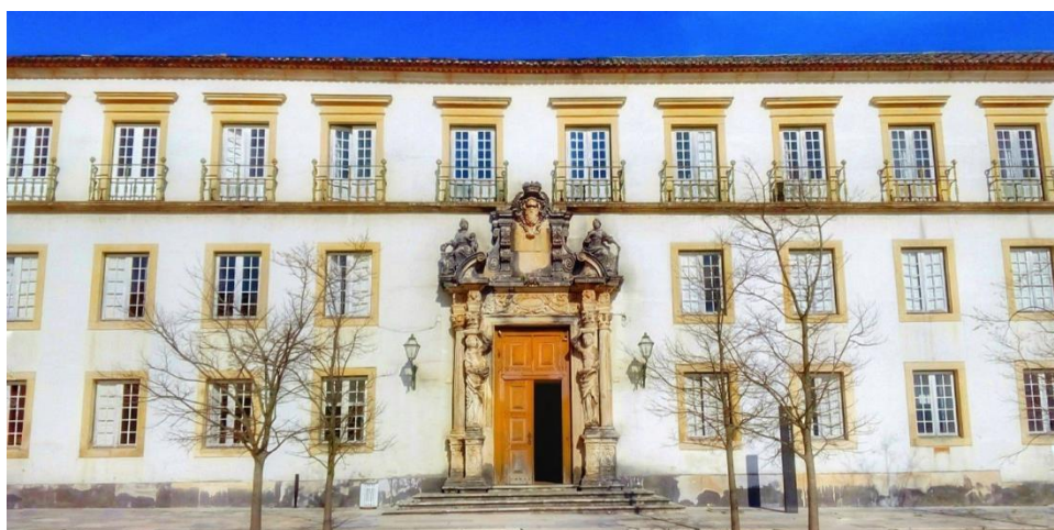
Fig. 78 – Colégio de São Pedro, no Pátio das Escolas. Fotografia: JCC, 2017.
