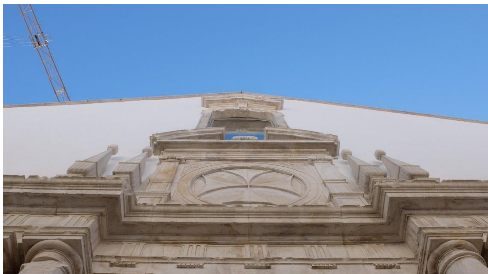
Fig. 79 – Colégio da Santíssima Trindade, pormenor do pórtico de entrada. Fotografia: JCC, 2016.
