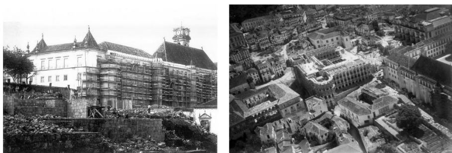
Fig. 43 – Duas fases de construção da FLUC 660 .
