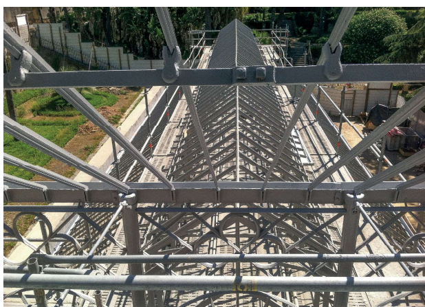
5. Foto durante o processo de recuperação da estrutura em ferro.
