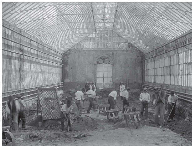
2. Imagem de testemunho dos trabalhos de remodelação do interior da Estufa do Jardim Botânico em 16 de maio de 1932.
