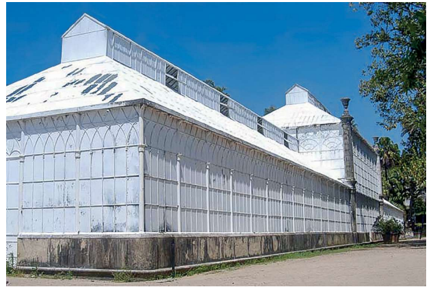
3. Exterior das estufas utilizando o processo de caiação, antes da recente obra de restauro.
