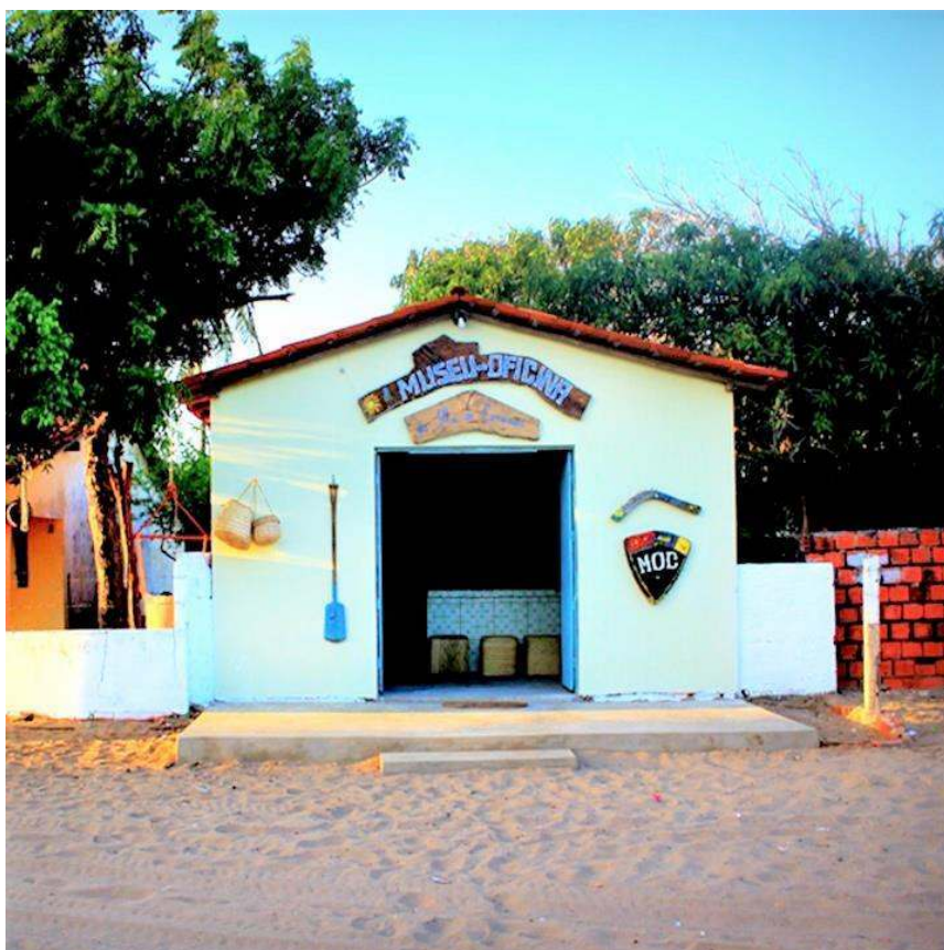
FIGURA 6 – Vista geral do MOC em finais de 2016
