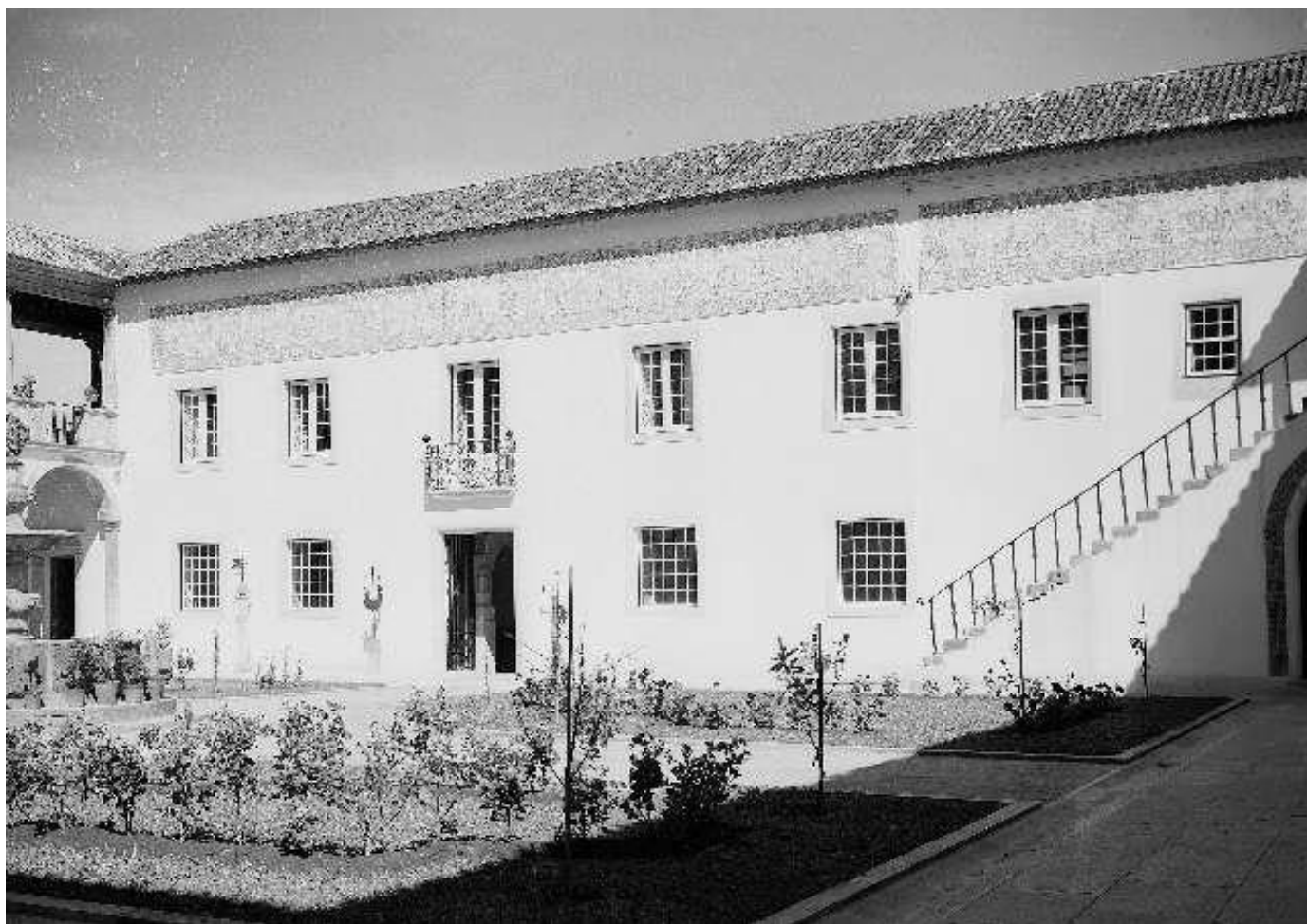
317 – Intervenção concluída na fachada Norte.
