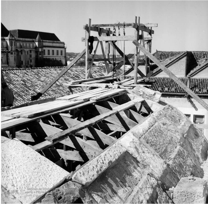
436 e 437 – Montagem da abóbada (1967).
