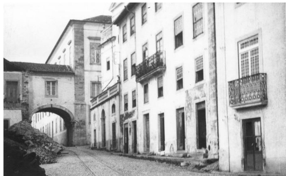
260 – Demolição das dependências do Museu de Arte Sacra e das salas do IC (finais de Abril de 1944).
