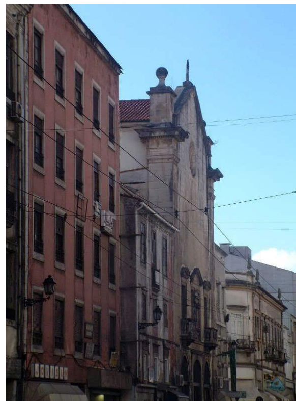
449 – Testeira da antiga igreja, voltada para a rua da Sofia (2004).
