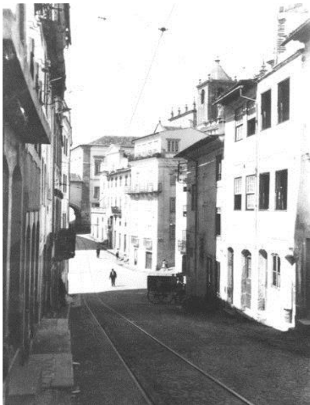
256 – Descida da rua de São João até ao arco do bispo. Os blocos residenciais que a ladeiam (á excepção do Museu Machado de Castro) foram demolidos para dar lugar à Faculdade de Letras (lado esquerdo) e à Faculdade de Medicina (lado direito).
