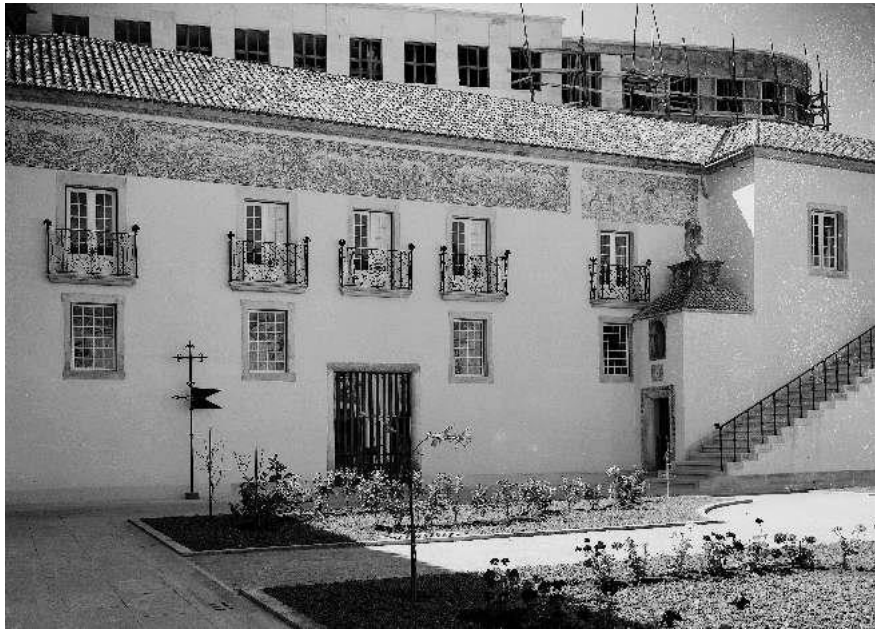
315 – Intervenção concluída na fachada Sul.
