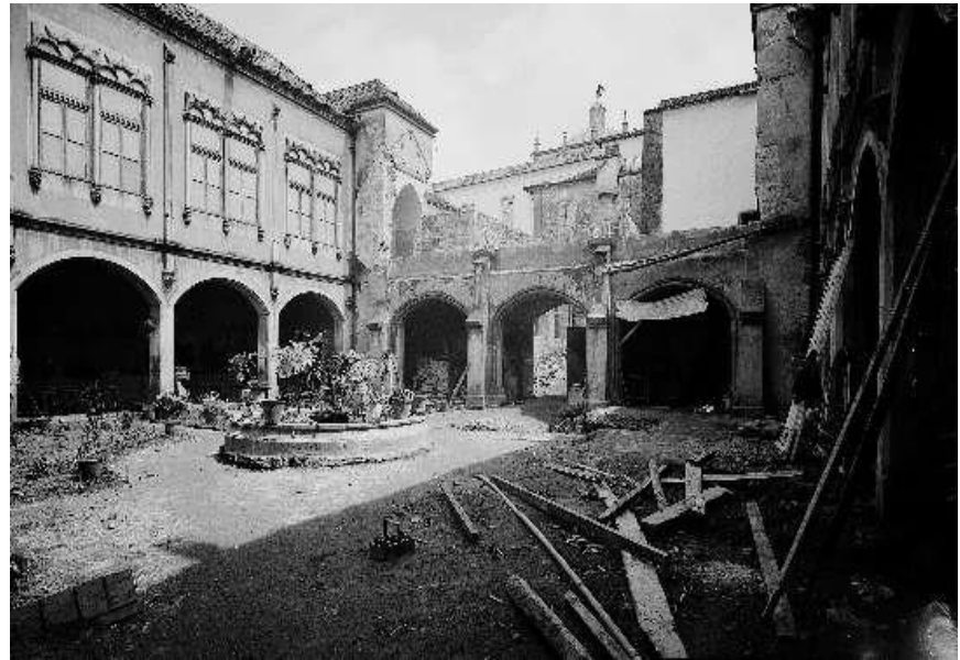
236 – Reforma do pátio interior.
