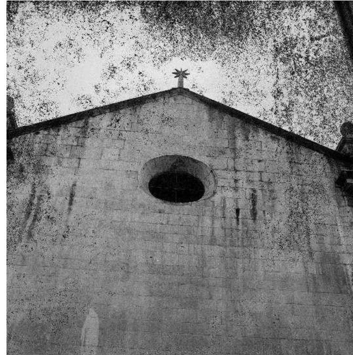
445 – Estrela de São Domingos a arrematar empena da cabeceira da igreja de São Domingos (1969).
