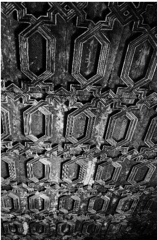
110 – Teto aplicado no primeiro andar do bloco Sul (fotografia da década de 1940). N.º inv.: MNMC 12177.
