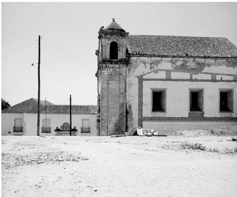
378 – Fachada lateral da igreja de São João de Almedina no período anterior à intervenção.
