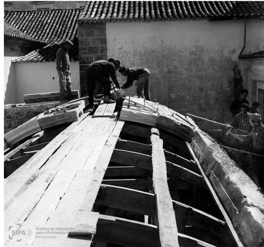
436 e 437 – Montagem da abóbada (1967).
