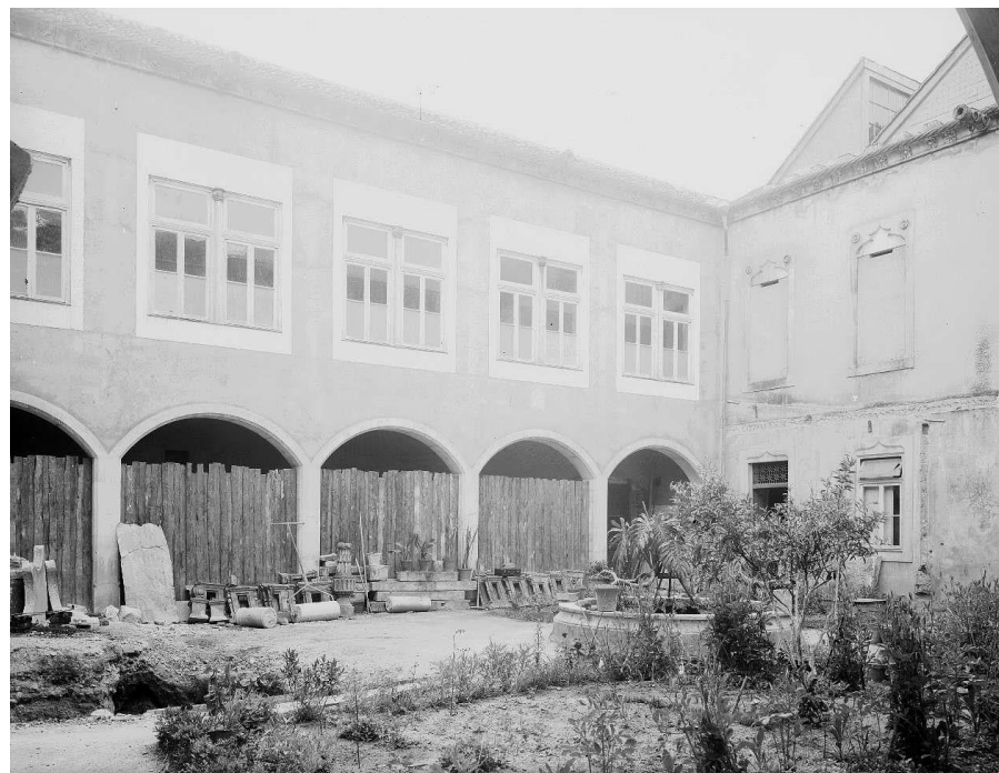
246 – Flanco Sul. Arcadas finalizadas.
