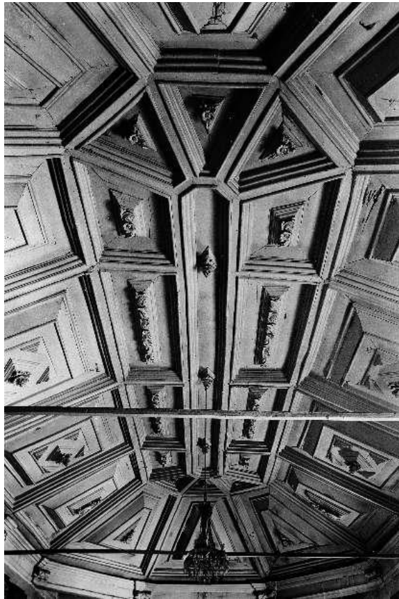
289 – Tecto do século XVII disposto no primeiro andar do bloco Sul (sala com janelas voltadas a Sul).
