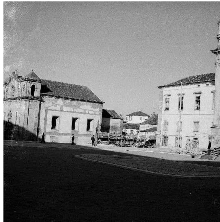
385 – Início da construção do anexo com a fachada voltada para a rua do Arco do Bispo (1956).
