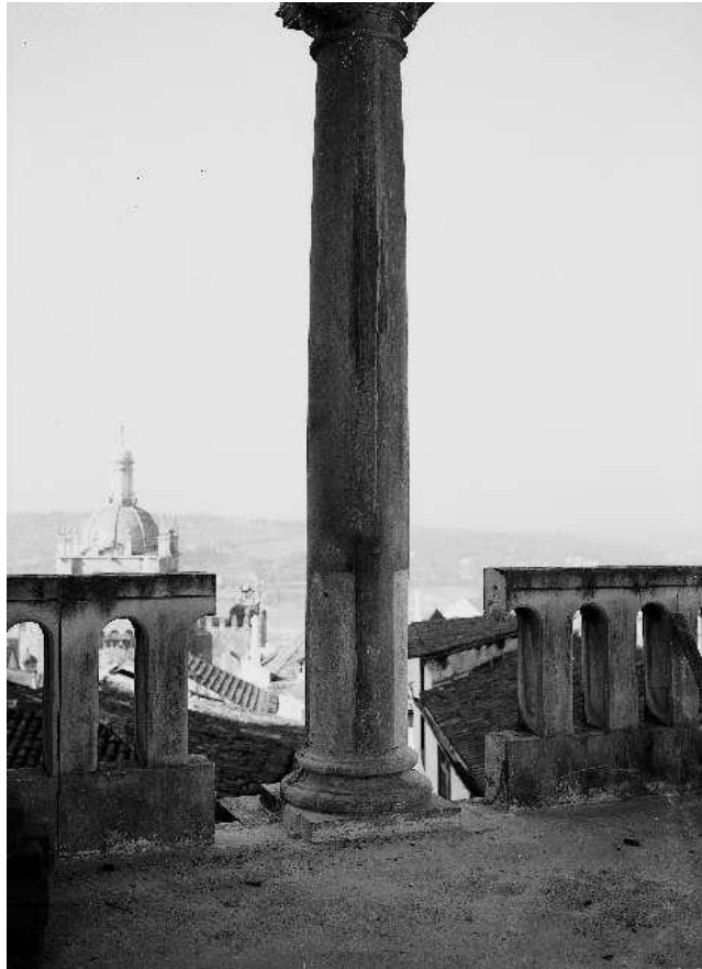
307 – Remoção da varanda em pedra da parte inferior da loggia .
