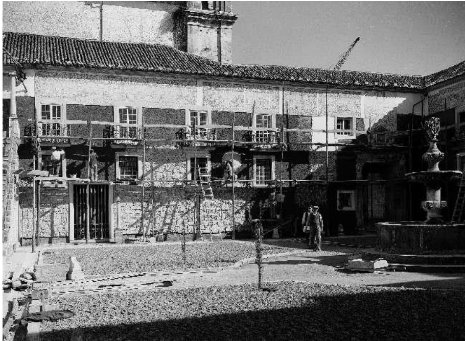
311 e 312 – Intervenções na fachada Nascente do pátio principal.
