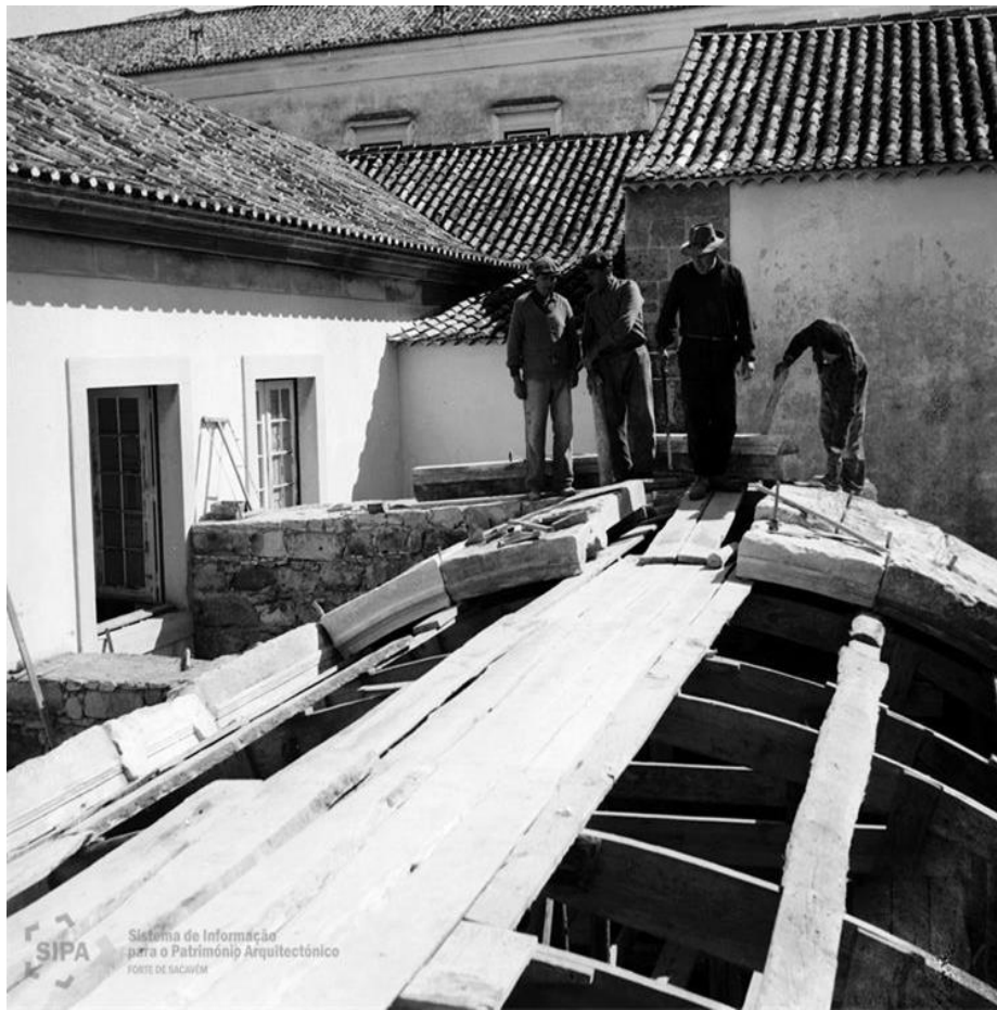
438 – Montagem da abóbada (1967).
