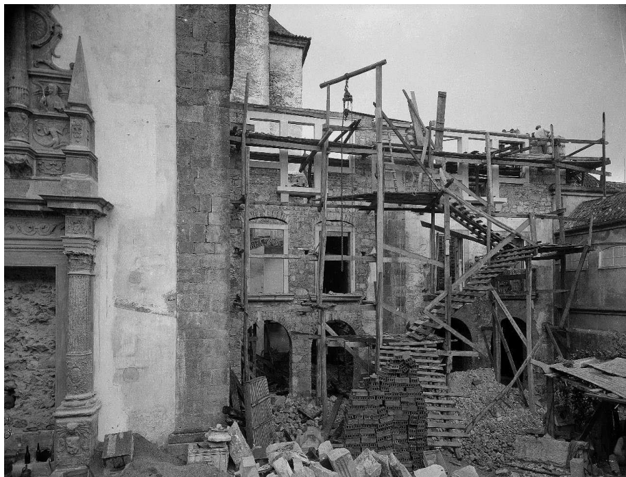
226 – No lado esquerdo: portal de Santo Agostinho adossado à cabeceira do templo. No lado direito: construção da fachada.
