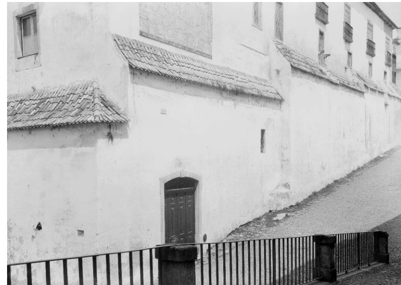
265 – Porta de entrada para o piso inferior do criptopórtico (década de 1930).
