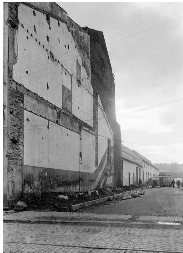
417 – Área onde se procedeu às demolições.
