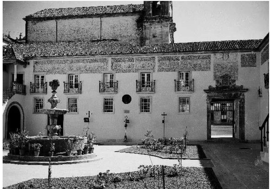
316 – Intervenção concluída na fachada Nascente.
