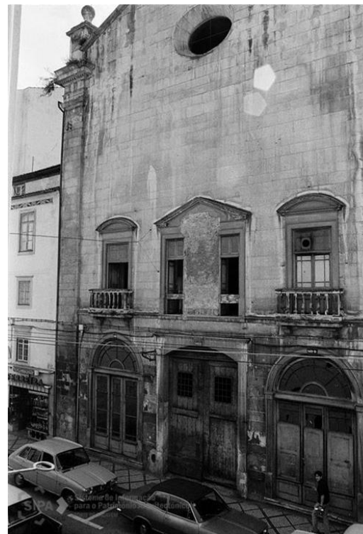
443 – Cabeceira do antigo tempo de São Domingos depois da retirada do brasão dos duques de Aveiro (1971).
