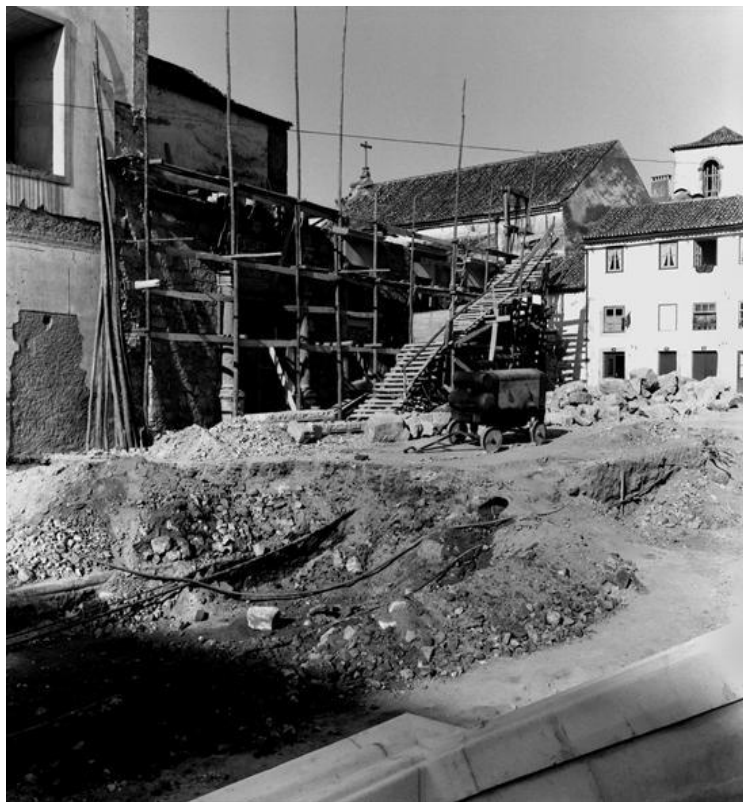
386 – Construção do anexo (1956-1957).
