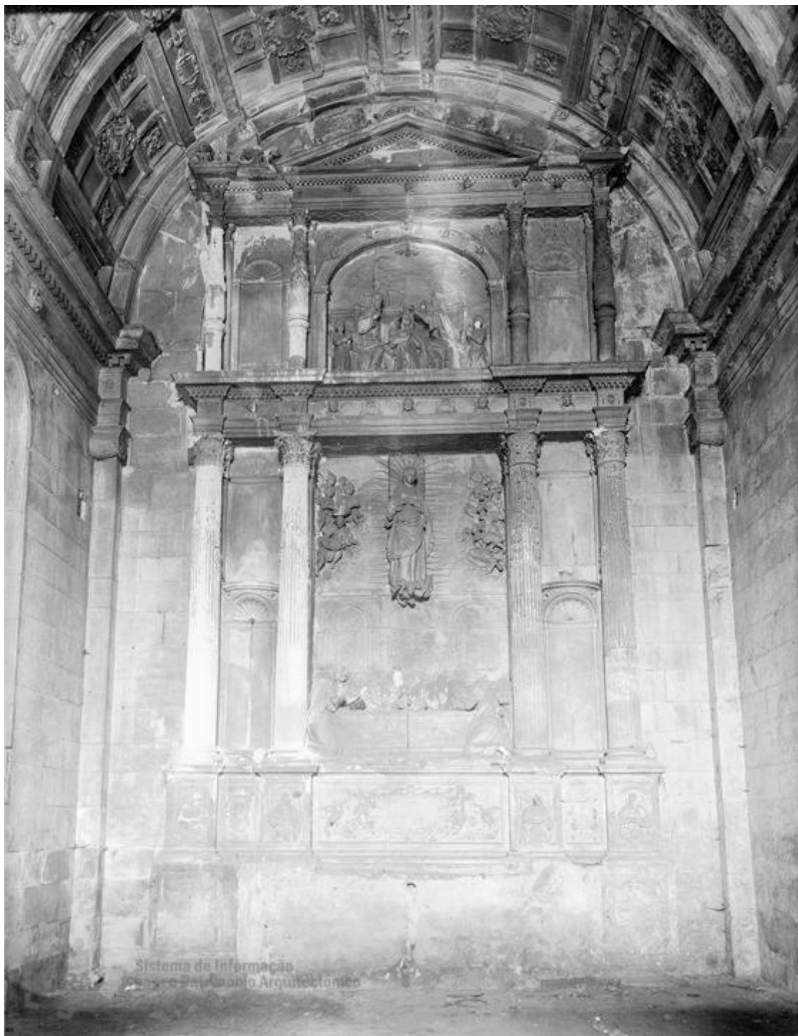
413 – Retábulo em mau estado de conservação.
