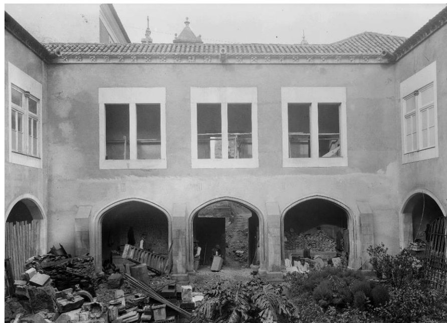
100 – Antigo pátio das cozinhas. Pormenor da cornija de cordas interlaçadas, elementos florais e desaguadouros em forma de canhão (finais da década de 1930).
