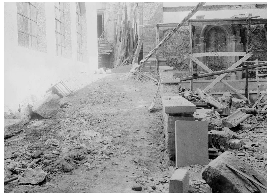
227 – No lado esquerdo: fachada já edificada. No lado direito: vestígios a antiga sacristia da igreja de São João de Almedina.
