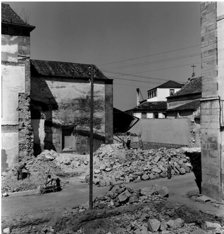
384 – Período anterior à construção do anexo (1956).
