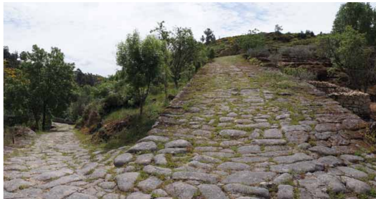
Fot. 11: Calçada e Ponte Velha de Murça (© P.C. Carvalho).
