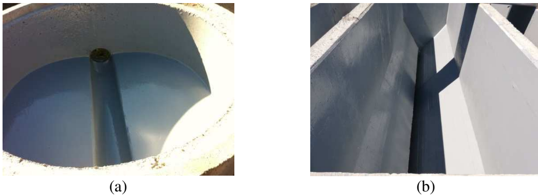
Figura 3.4 - Revestimento de (a) interior de caixa de visita e de (b) elemento de uma ETAR com Mapecoat I 24.
