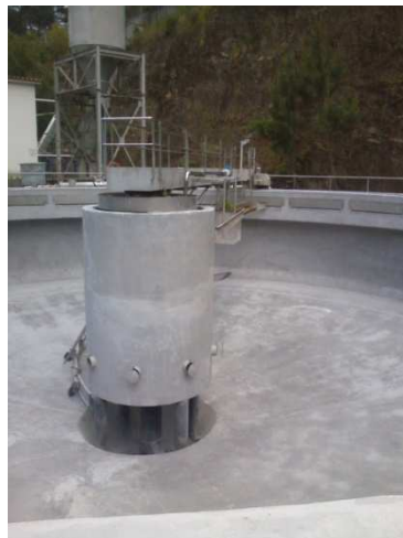
Figura 3.2 - Revestimento de decantador de uma ETAR com Sewament 10.
