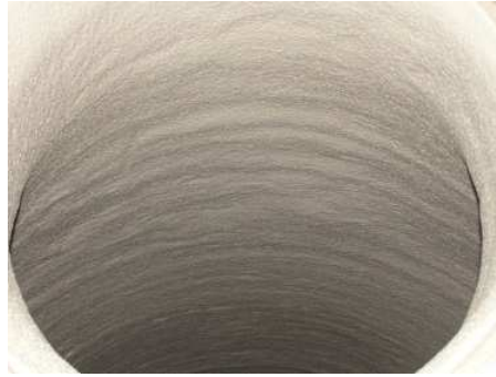
Figura 3.3 - Revestimento de interior de uma caixa de visita com Sewament 10.
