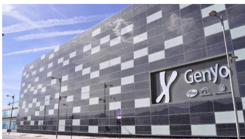
Figura 3 – Sistema BIPV: Fachada fotovoltaica ventilada no Centro de Investigação Oncológica e Genómico (GENyO) da Pfizer-Universidade de Granada-Junta de Santa Luzia desenhado pela Onyx Solar. Geração anual média de 32MWh [17].
