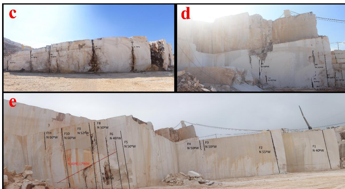
Figura 67 - Frentes "c" "d" e "e" e respetivas descontinuidades.
