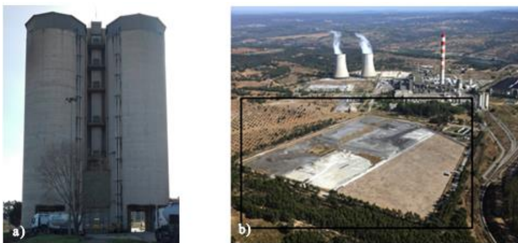
Figura 3.5 – a) silos de armazenamento principais de cinza volante; b) vista aérea do aterro de cinzas.
