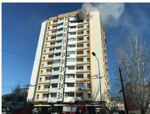
Figura 11 - Fotografia incêndio urbano da Solum (Fonte:
