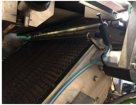
Figura 4.7. Implementação do tubo microperfurado dentro da Baumer pela equipa da manutenção
