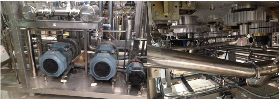
**Figura 14.1** Exemplos de atividades realizadas pela empresa externa: Bombas da plataforma APA-AE e substituição de juntas dos tubos de alimentação situadas debaixo do isolador
