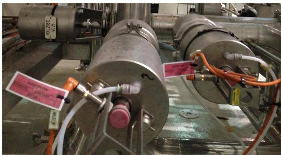
**Figura 23.** Válvulas identificadas com etiquetas criadas
