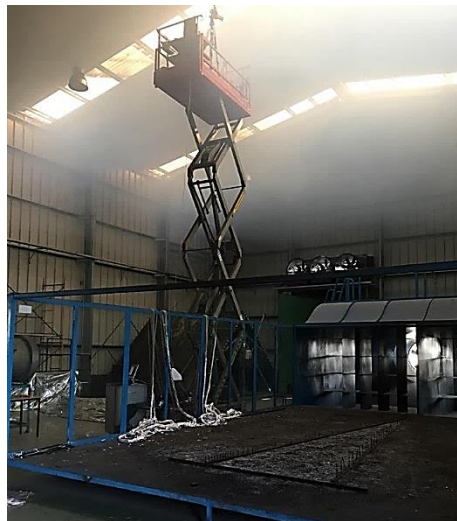
Figura 4.2 Fotografia da plataforma elevatória sobre o leito de combustível
