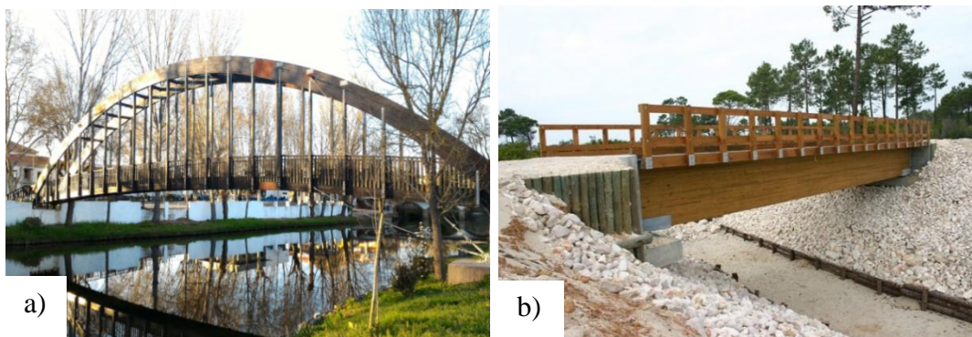
Figura 1.2 – Estruturas com MLC: a) Ponte pedonal, Sertã, b) Ponte rodoviária em Quiaios, Figueira da Foz (Cortesia J. Rodrigues)
