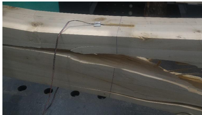
Figura 6.10 – Instrumentação de viga com extensómetros dispostos na lamela de compressão e de tração
