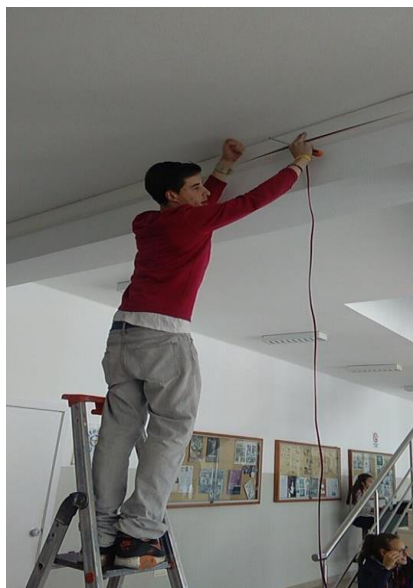
Figura 1 – Passagem de cabos para instalação de colunas
