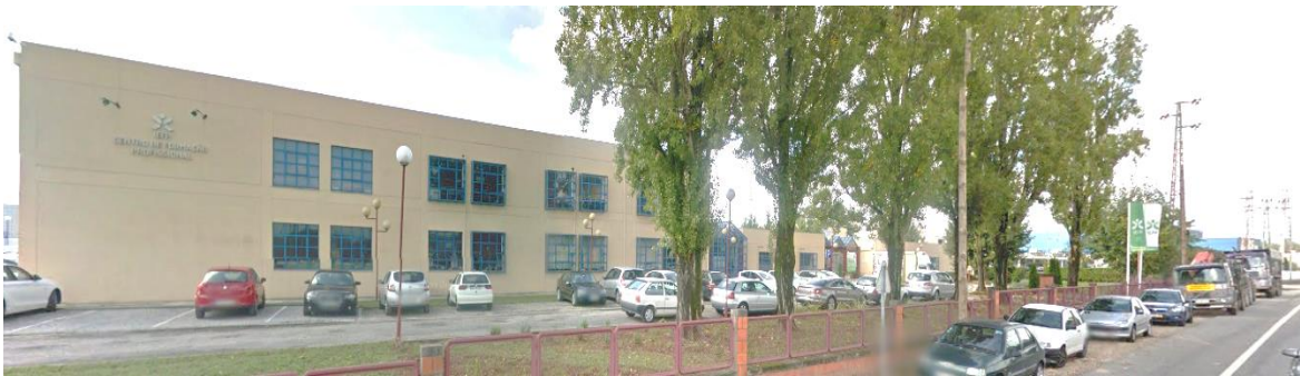
Figura 2 - Fachada dianteira do SFPA (Google Maps, 2017)
