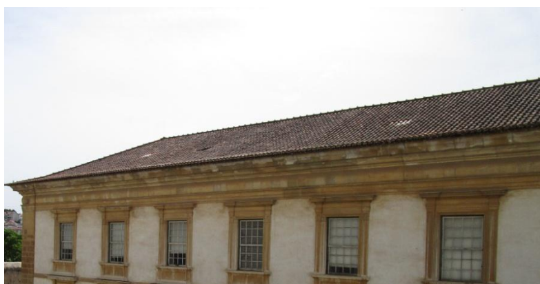
Figura 69: Telhado do alçado noroeste do DCV
