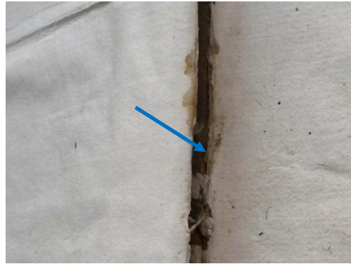
Figura 309: Desintegração da charneira, cujas costuras são visíveis, e sinal de manchas de cola
