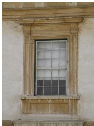
Figura 68: Janela do alçado noroeste do DCV
