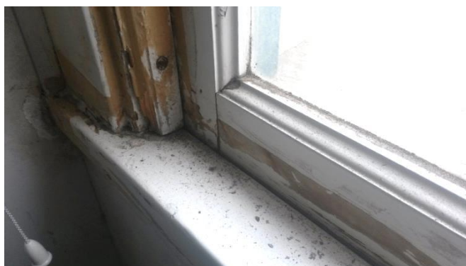
Figura 70: Interior da janela do Depósito de Antropologia, do alçado noroeste
