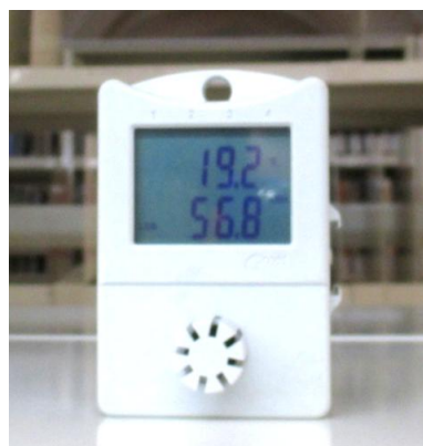
Figura 43: Datalogger da sala de leitura da Biblioteca do DCV
